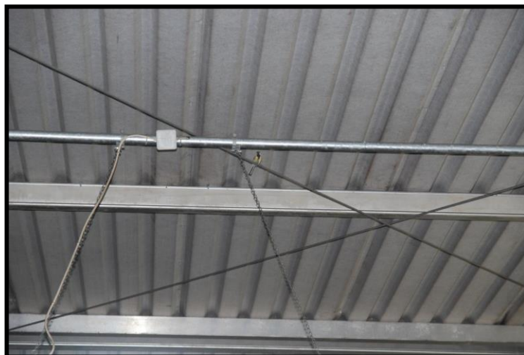
Singvogelnachweis in Lagerhalle REMAG Nordost
