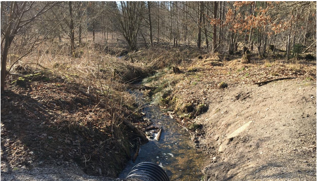
Abb. 17: Gewässerdurchlass am Katzensgraben
