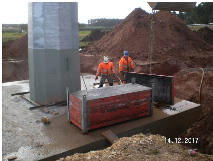
Abbildung 2: Plattenfundament eines Stahlvollwandmastes
