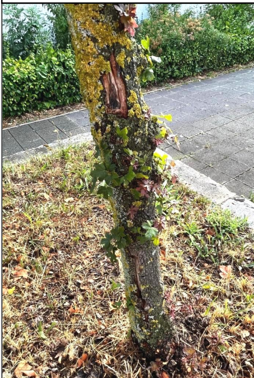
Abb. 7.3-11: Rindenschaden am Stamm; keine Habitatstruktur
