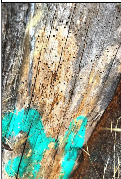
Abb. 7.3-38: Rindenschaden mit Bohrlöchern am Stammfuß
