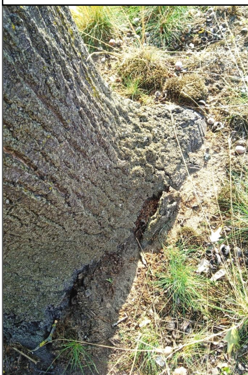
Abb. 7.3-51: keine Schäden am Stammfuß
