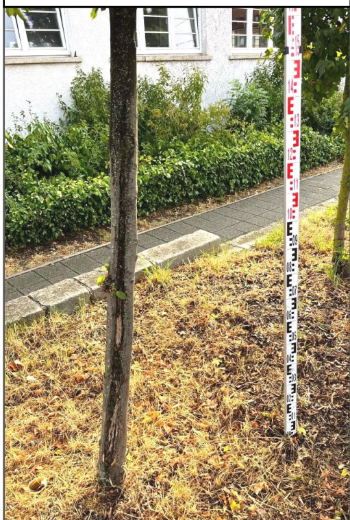
Abb. 7.3-05: Rindenschaden am Stamm
