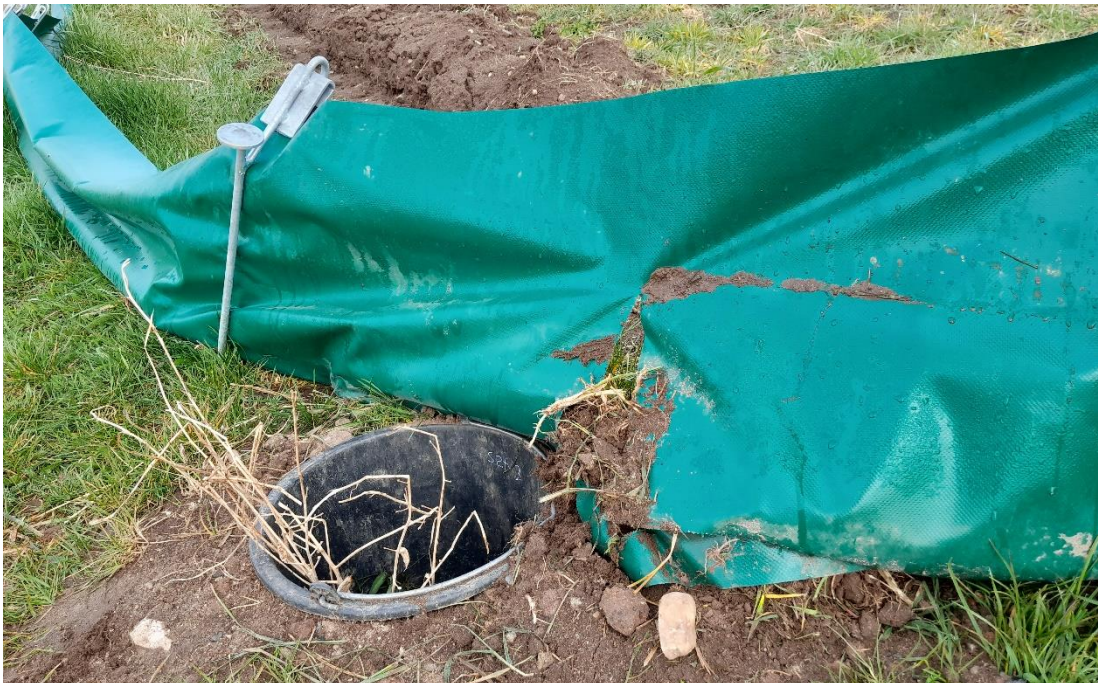
Abbildung 6: Lokale Zerstörung des Amphibienzaunes durch den Einsatz landwirtschaftlicher Fahrzeuge in angrenzenden Flächen
