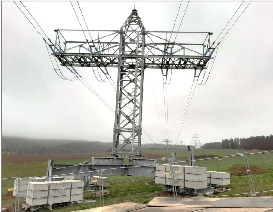
**Abbildung 4** Beispiel für einen provisorischen Masten entlang der A120 (Foto: JENA-GEOS)
