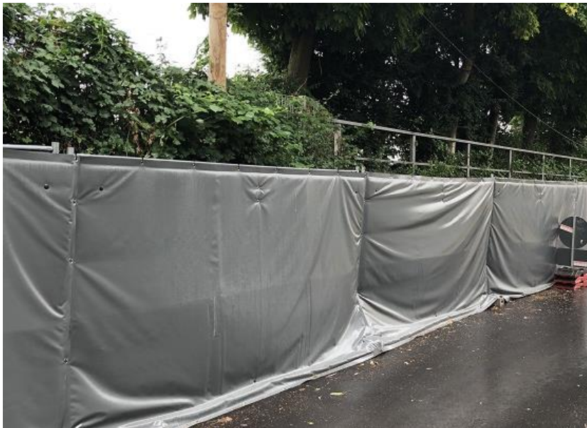
Abbildung 4: Exemplarische Darstellung mobiler Lärmschutzwände etc.
