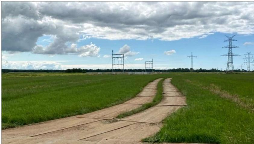
Abbildung 2: Beispiel Lastverteilplatten (Stahl-Baggermatten) als Zuwegung zur Arbeitsfläche
