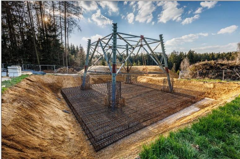
Abbildung 11: Herstellung eines Plattenfundaments (TENNET, 2023b)
