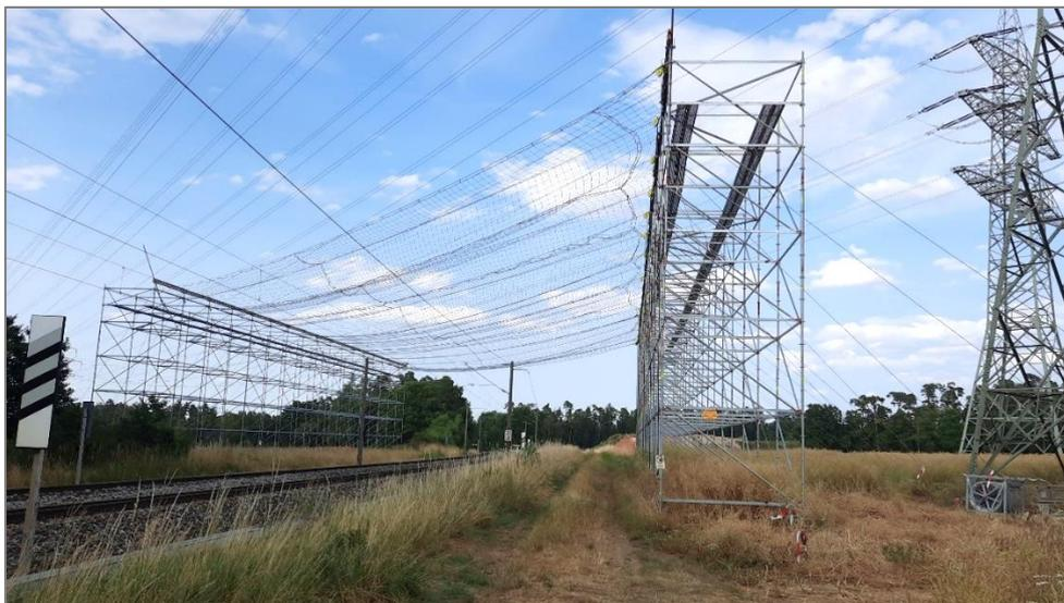
Abbildung 15: Schutzgerüst aus Metall mit Schutznetz
