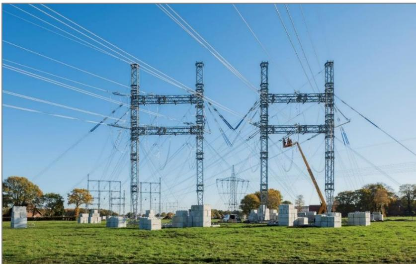
Abbildung 8: Freileitungsprovisorium für zwei 380-kV-Stromkreise
