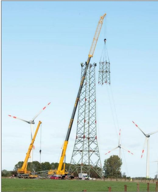
Abbildung 12: Mastmontage mittels Mobilkran
