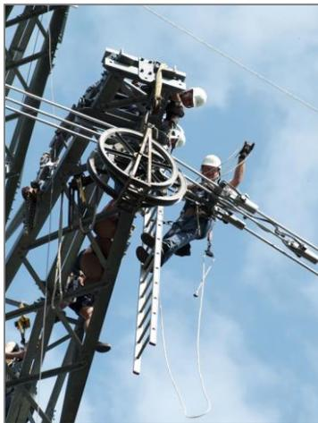
Abbildung 14: Aufliegen der Leiterseile in Laufrollen während des Seilzugs
