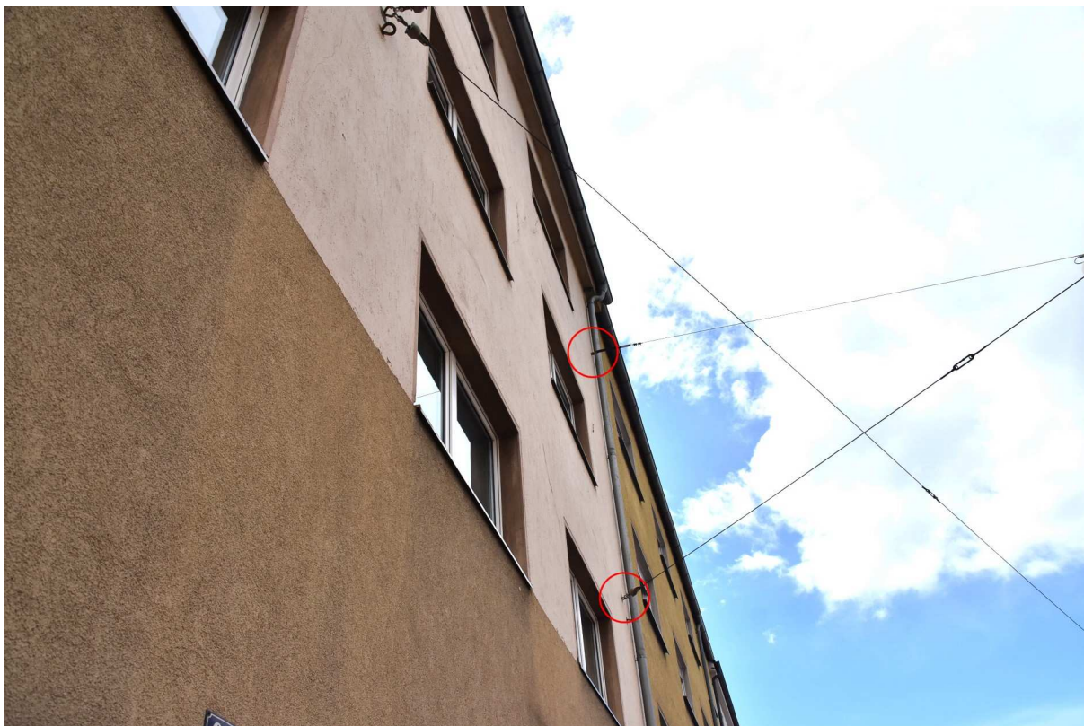
Abb. 6: Befestigung Straßenbahnoberleitung (Foto FEHSE 18.04.2024)
