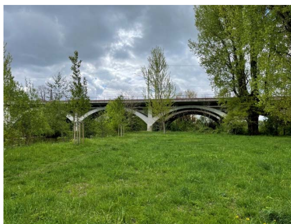
Abb. 13: Siebenbogenbrücke, Blickrichtung Süden
