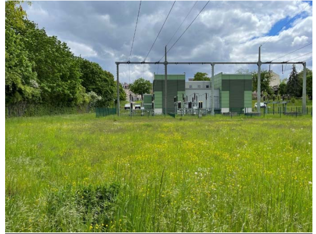
Abb. 15: Umspannwerk Dambacher Straße, Blickrichtung Osten
