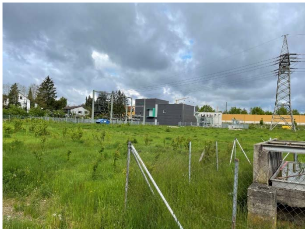
Abb. 2: Umspannwerk Vacher Straße am nördlichen Trassenbeginn
