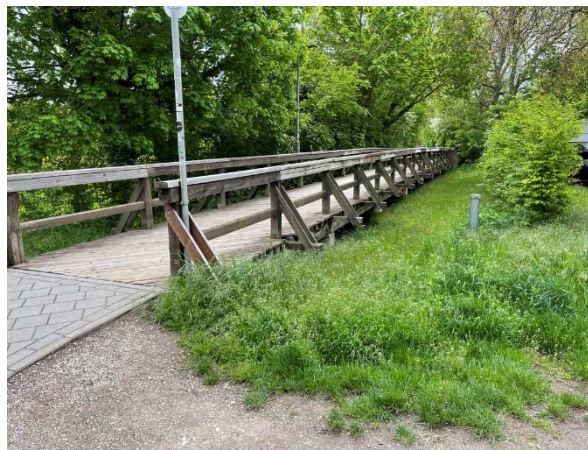
Abb. 9: Holzbrücke im Zuge des Hardstegs Blickrichtung Osten
