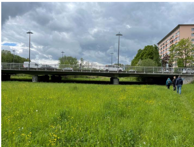
Abb. 8: Flutbrücke im Zuge der Hochstraße, Blickrichtung Süden
