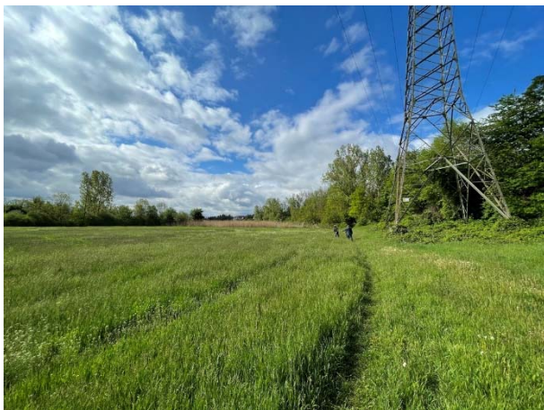
Abb. 4: Blick von Mast 24, G305 nach Südwesten
