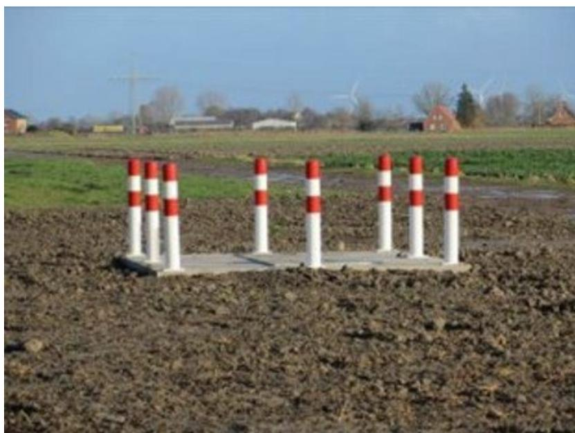
Abbildung 25: Cross-Bonding-Bauwerk mit Sicherheitspfosten
