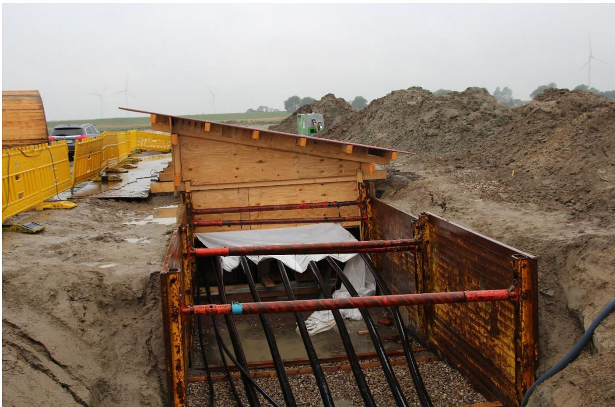
Abbildung 23: Bild eines Muffenverbaus
