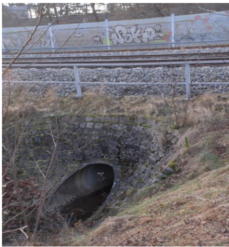
Durchlass des Entengrabens unter S-Bahn und Schallschutzwand
