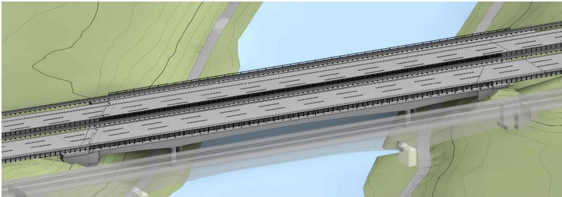
Abbildung 1: BW 404a – Bestand mit Plattenbalken
