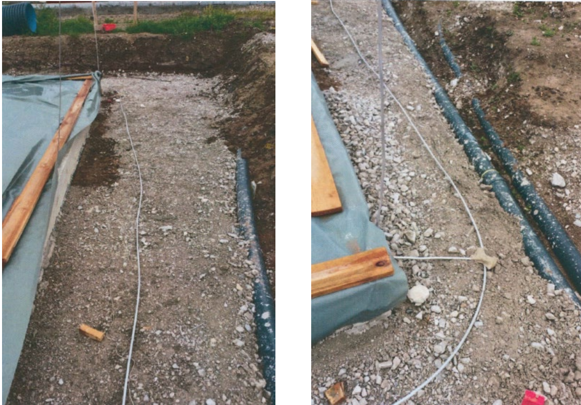
Abbildung 3: Erdungssystem
