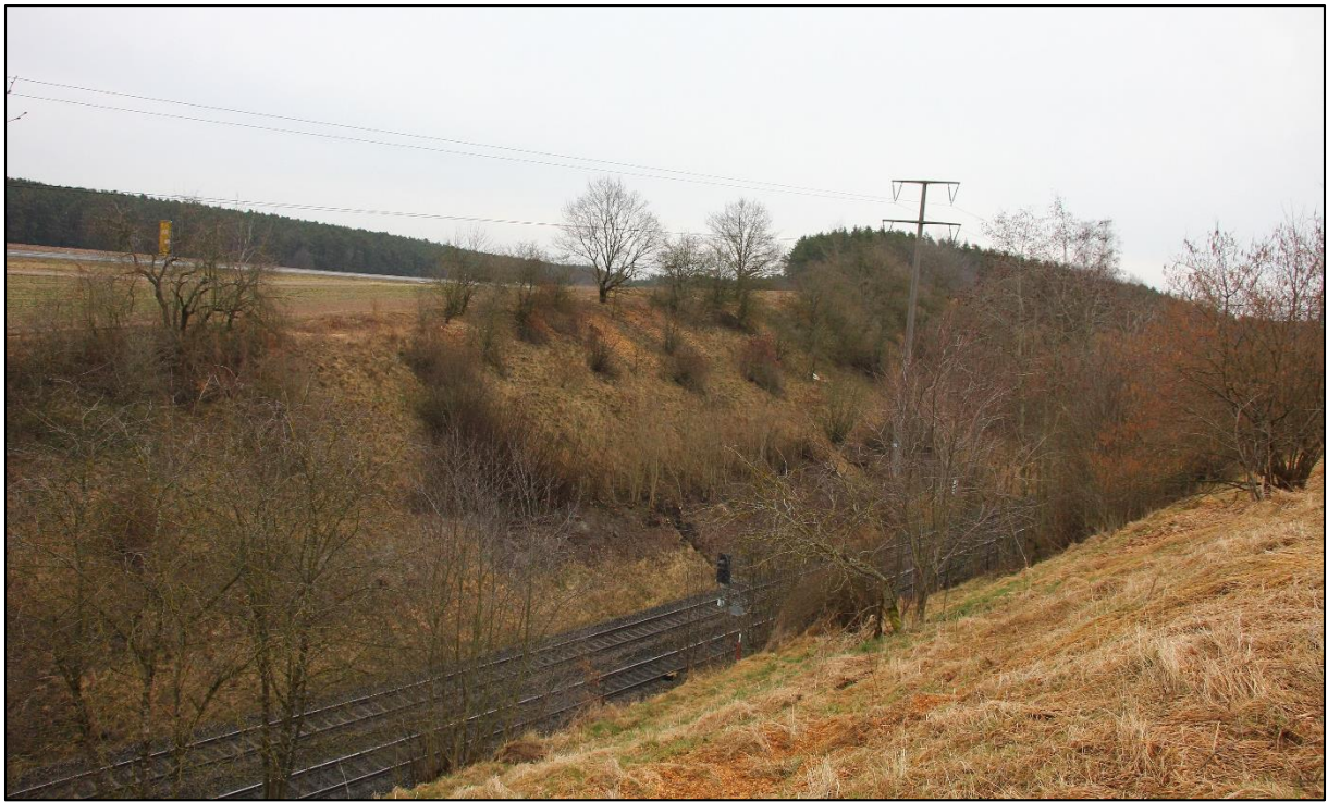
Abbildung 8: Böschungsbereiche westlich der geplanten Überführung. Foto: M. Bull, 15.03.2022.
