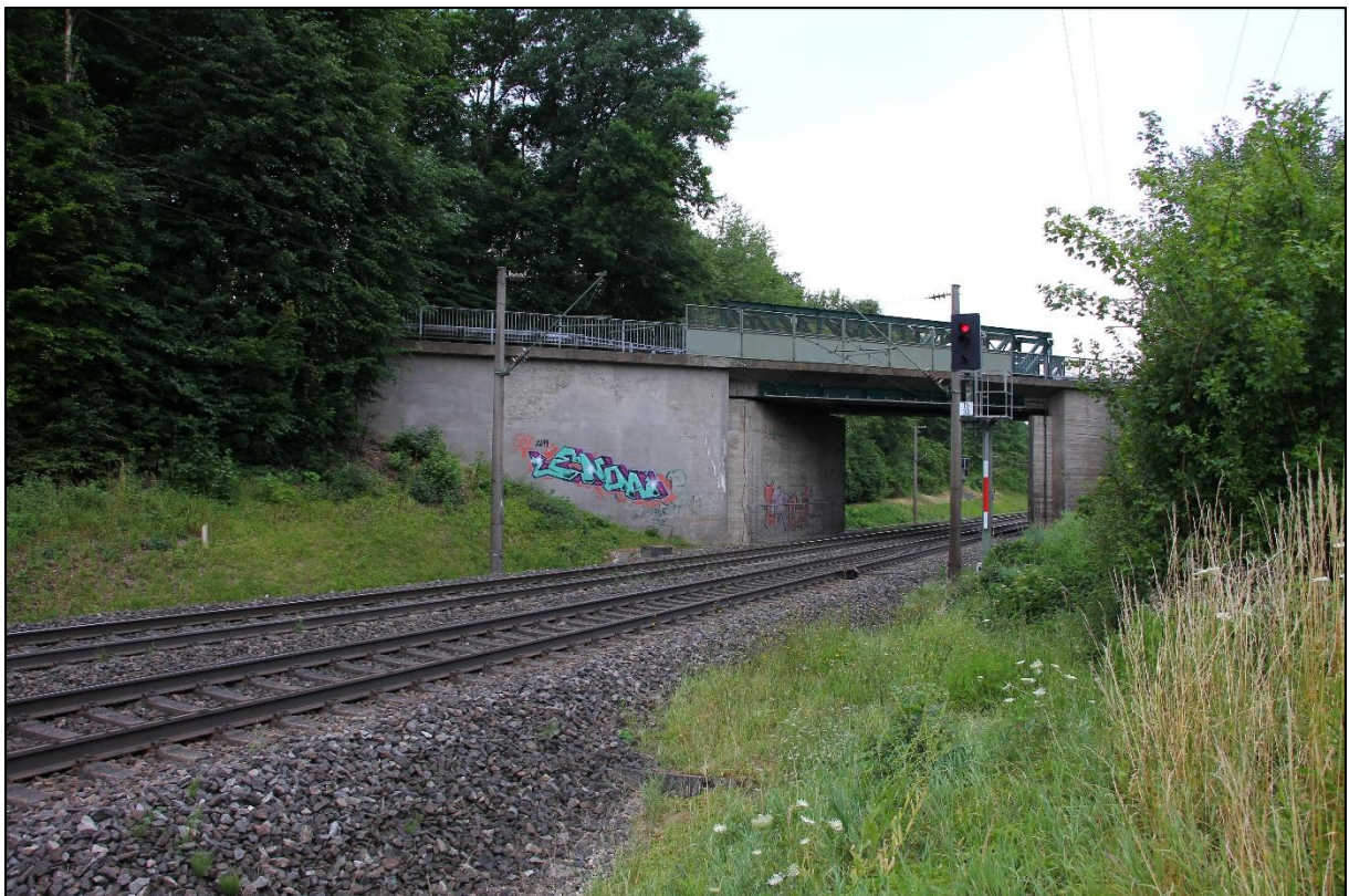
Abbildung 5: Aktuelle Brücke über die Bahnlinie Würzburg - Nürnberg. Foto: M. Bull, 07.07.2022.
