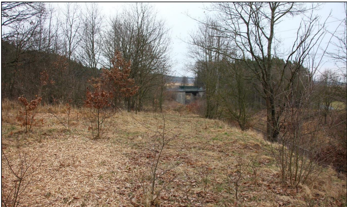
Abbildung 7: Hierzu wird hier bei der Vorhabensumsetzung ein Zufahrtsweg zu den Gleisen eingerichtet. Foto: M. Bull, 15.03.2022.
