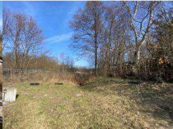
Abb. 36: Regenrückhaltebecken bei der Überführung Fischbacher Hauptstraße
