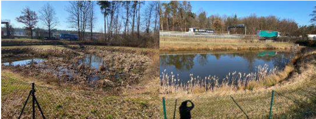
Abb. 43: Regenrückhaltebecken westlich der BAB A9
