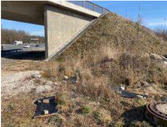
Abb. 35: Ruderale Verkehrsnebenfläche bei der Überführung Fischbacher Hauptstraße
