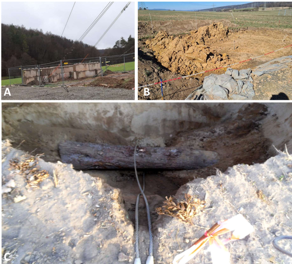
Abbildung 5 Zwei verbreitete Varianten um Masten während des Seilzuges abzuankern: A) Auflastanker B & C) ein sogenannter Totmannanker (C = Blick in die Baugrube)
