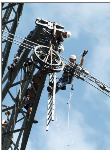
Abbildung 18: Aufliegen der Leiterseile in Laufrollen während des Seilzugs
