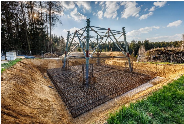
Abbildung 15: Herstellung eines Plattenfundaments (TENNET, 2023b)
