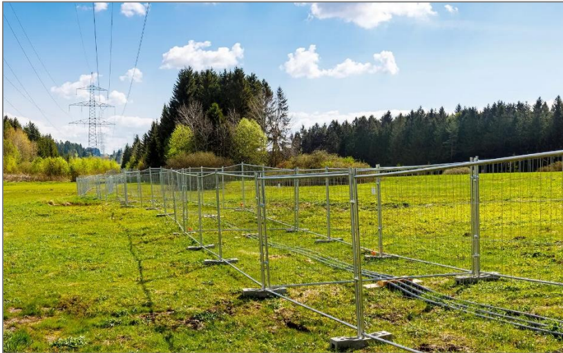
Abbildung 12: Verlegung eines Baueinsatzkabels (TENNET, 2023a)
