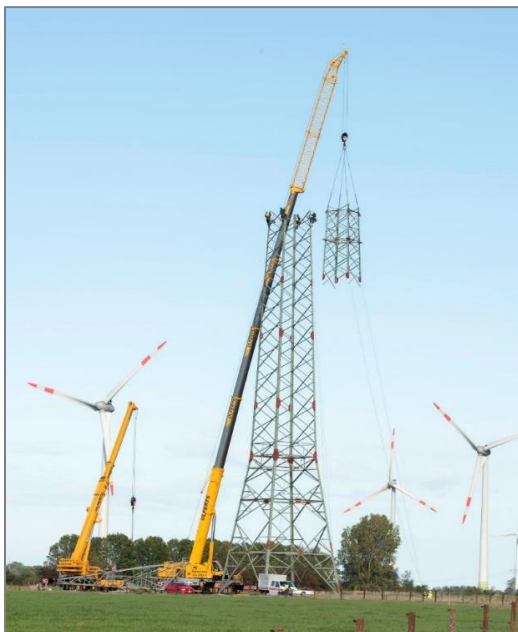
Abbildung 16: Mastmontage mittels Mobilkran
