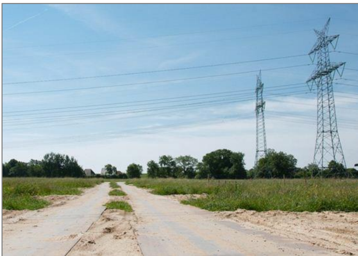
Abbildung 13: Beispiel für eine temporäre Mastzufahrt
