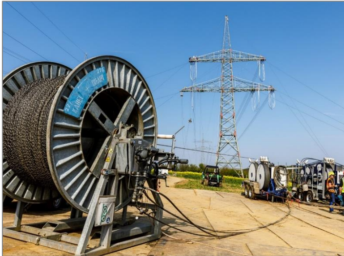
Abbildung 17: Trommelplatz beim Seilzug
