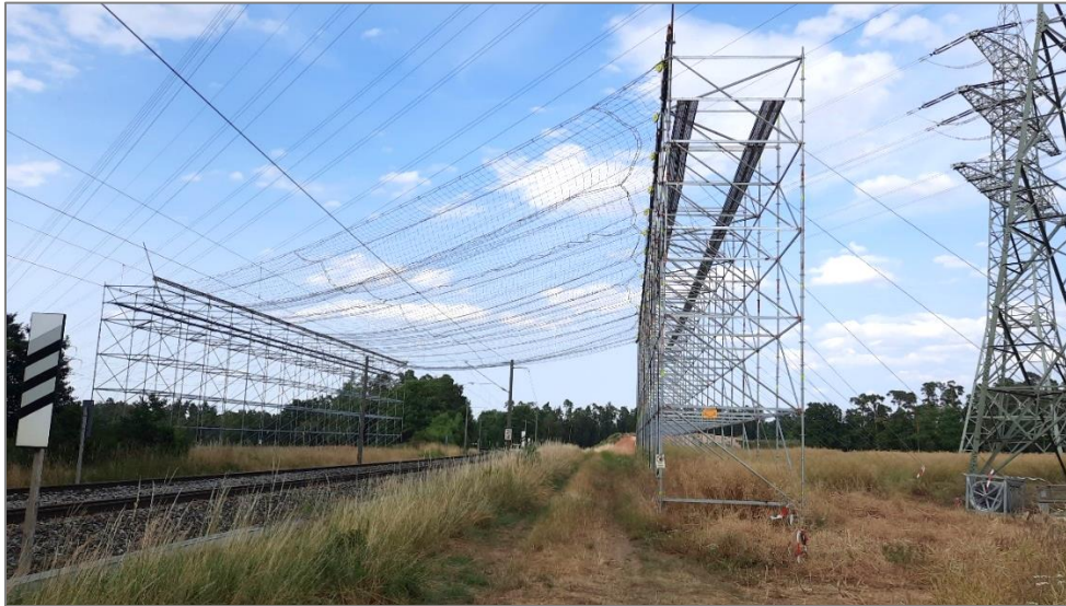
Abbildung 19: Schutzgerüst aus Metall mit Schutznetz
