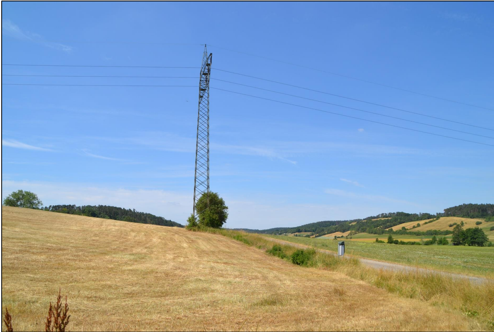
Abbildung 25: Mast Nr. 362 (seitlich)
