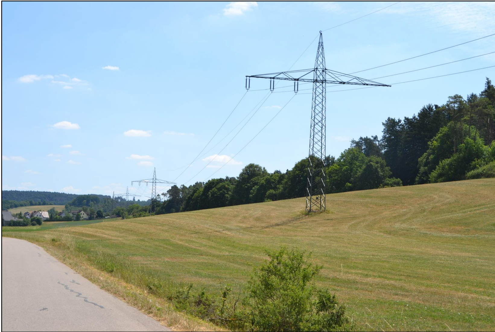
Abbildung 29: Mast Nr. 366 (gegen Leitungsrichtung)
