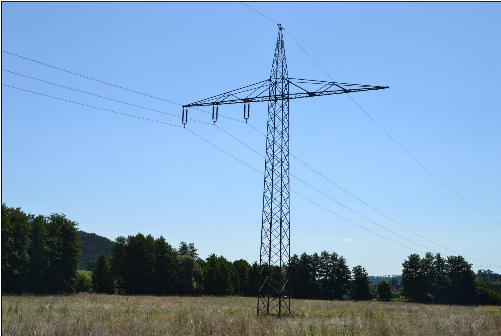
Abbildung 47: Mast Nr. 384 (gegen Leitungsrichtung)
