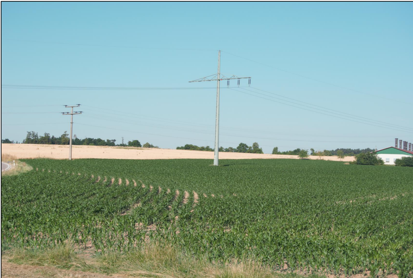
Abbildung 1: Mast Nr. 338 (Ersatzneubau nicht Teil des Vorhabens – nur Leiterseilwechsel)
