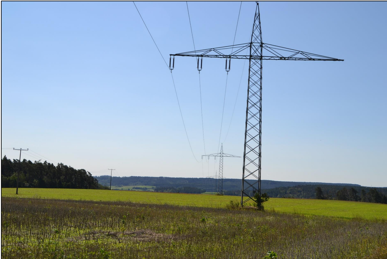
Abbildung 52: Mast Nr. 389 (gegen Leitungsrichtung)
