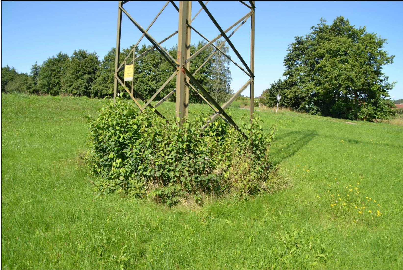
Abbildung 46: Mast Nr. 383 (Mastfuß)
