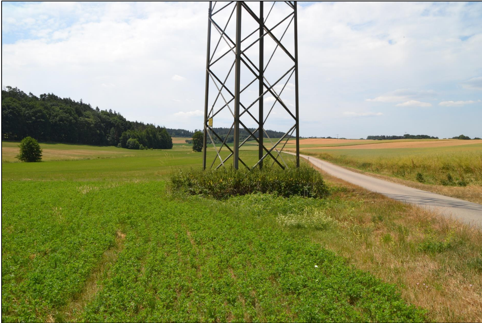
Abbildung 37: Mast Nr. 374 (Mastfuß)
