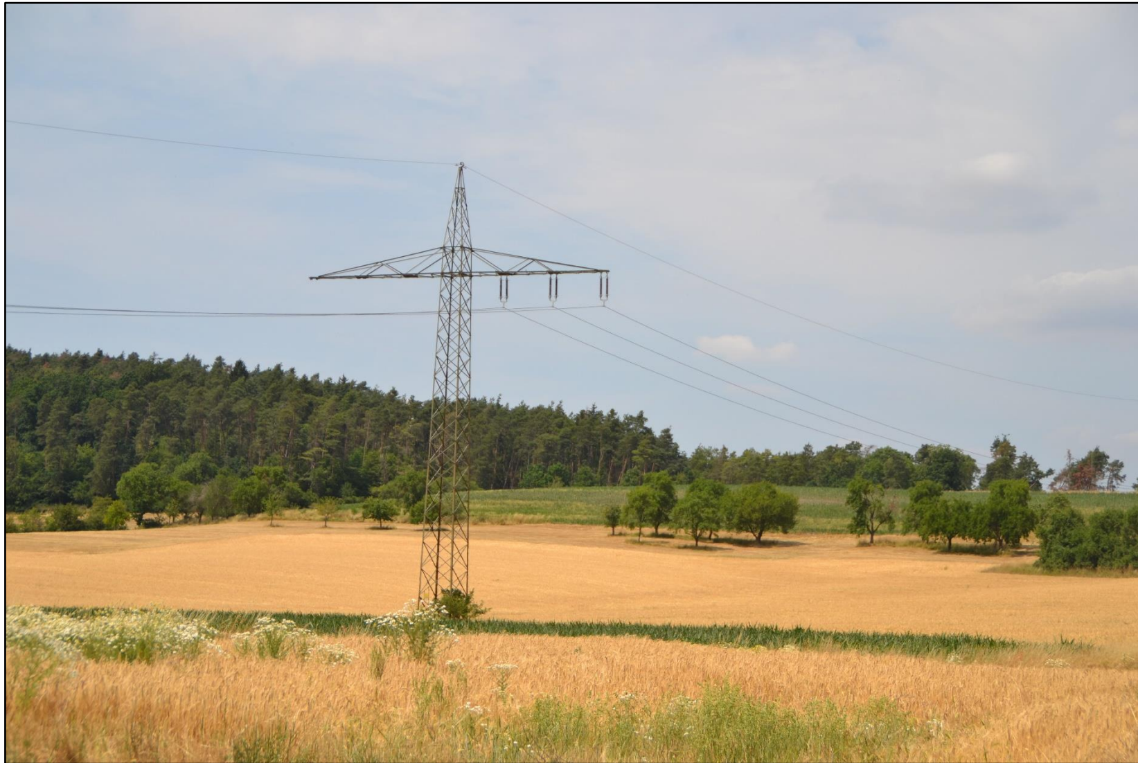
Abbildung 41: Mast Nr. 378 (in Leitungsrichtung)
