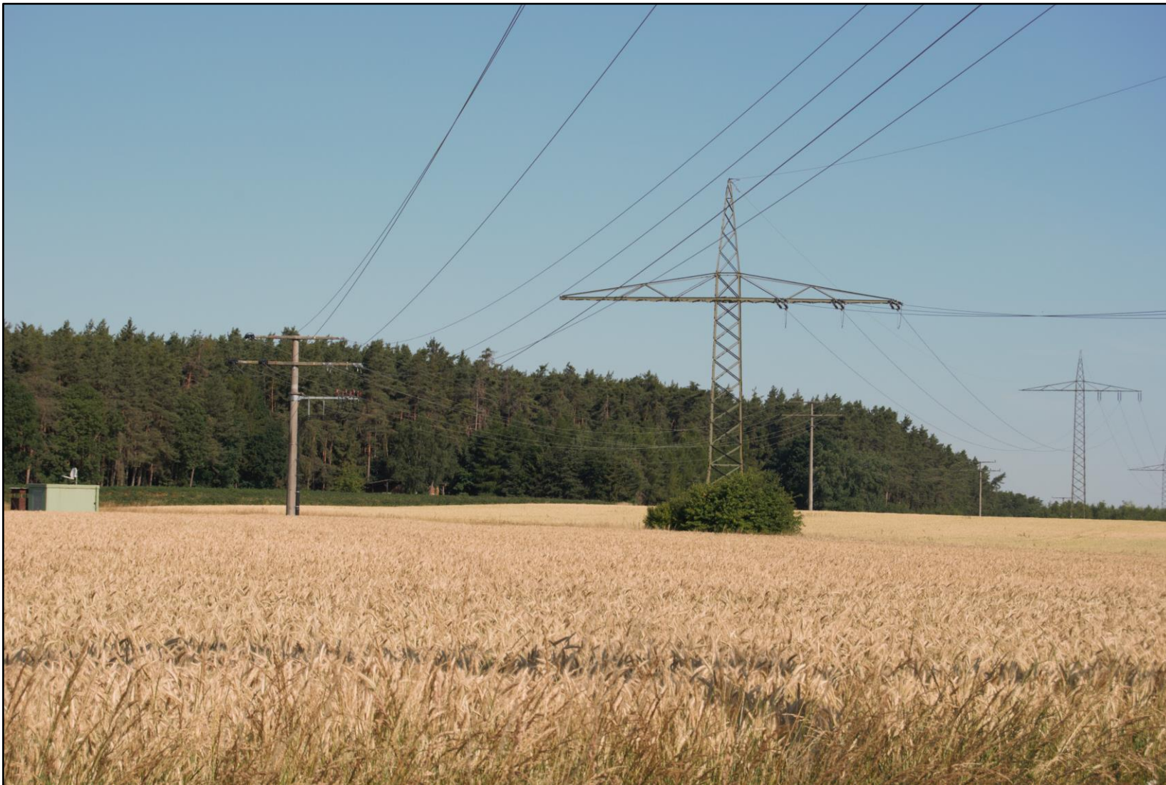
Abbildung 4: Mast Nr. 341 (in Leitungsrichtung)
