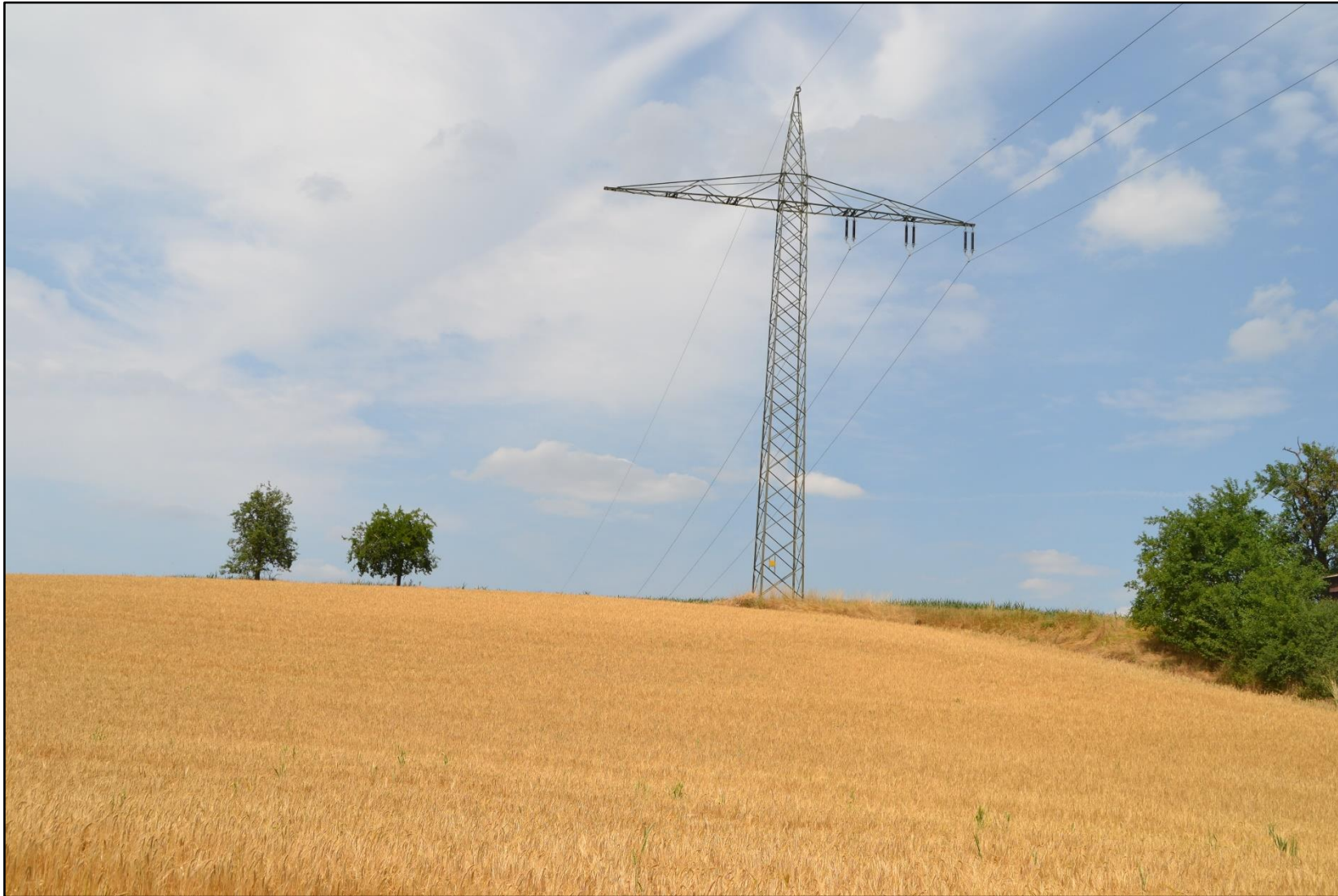
Abbildung 43: Mast Nr. 380 (in Leitungsrichtung)
