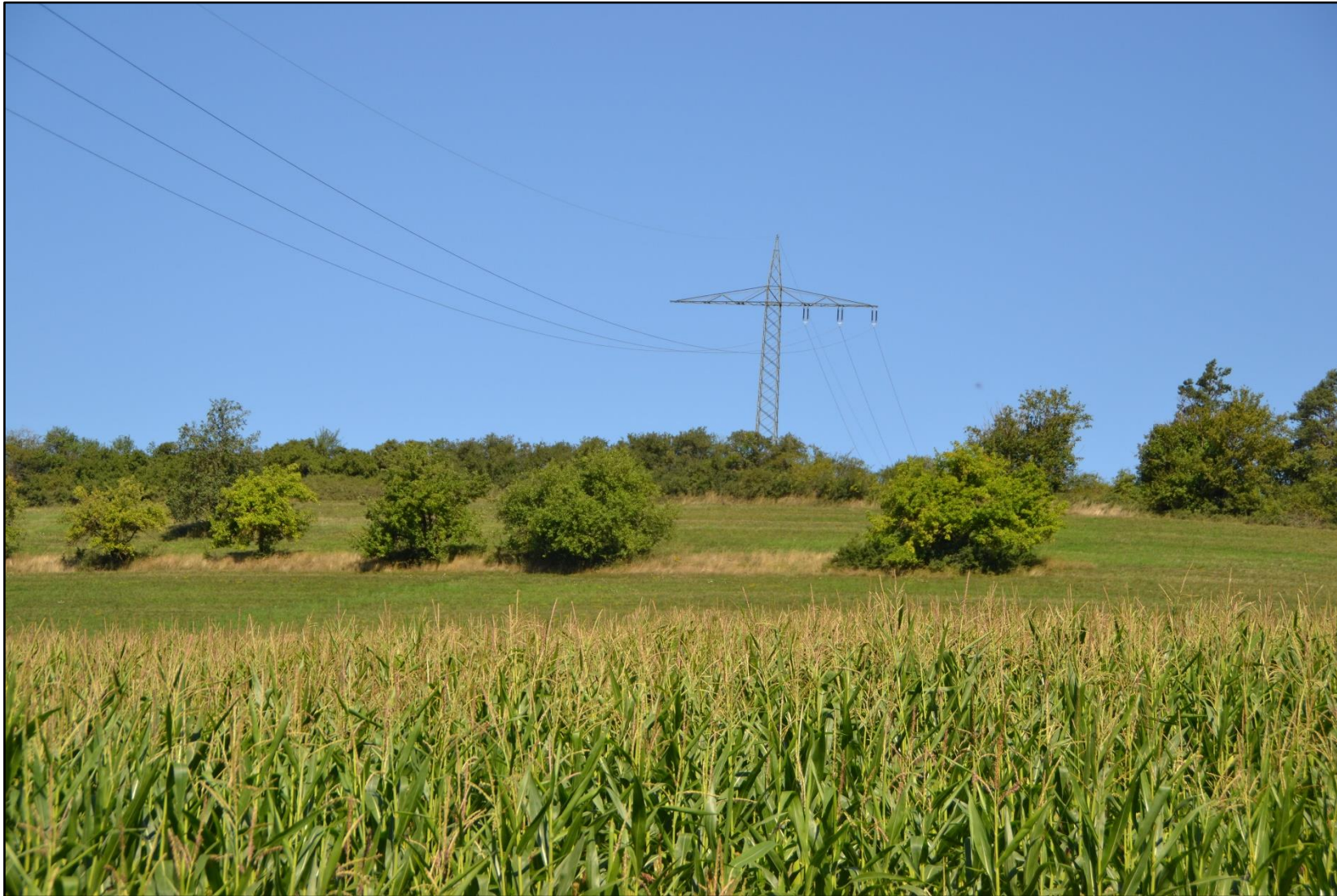
Abbildung 50: Mast Nr. 387 (in Leitungsrichtung)
