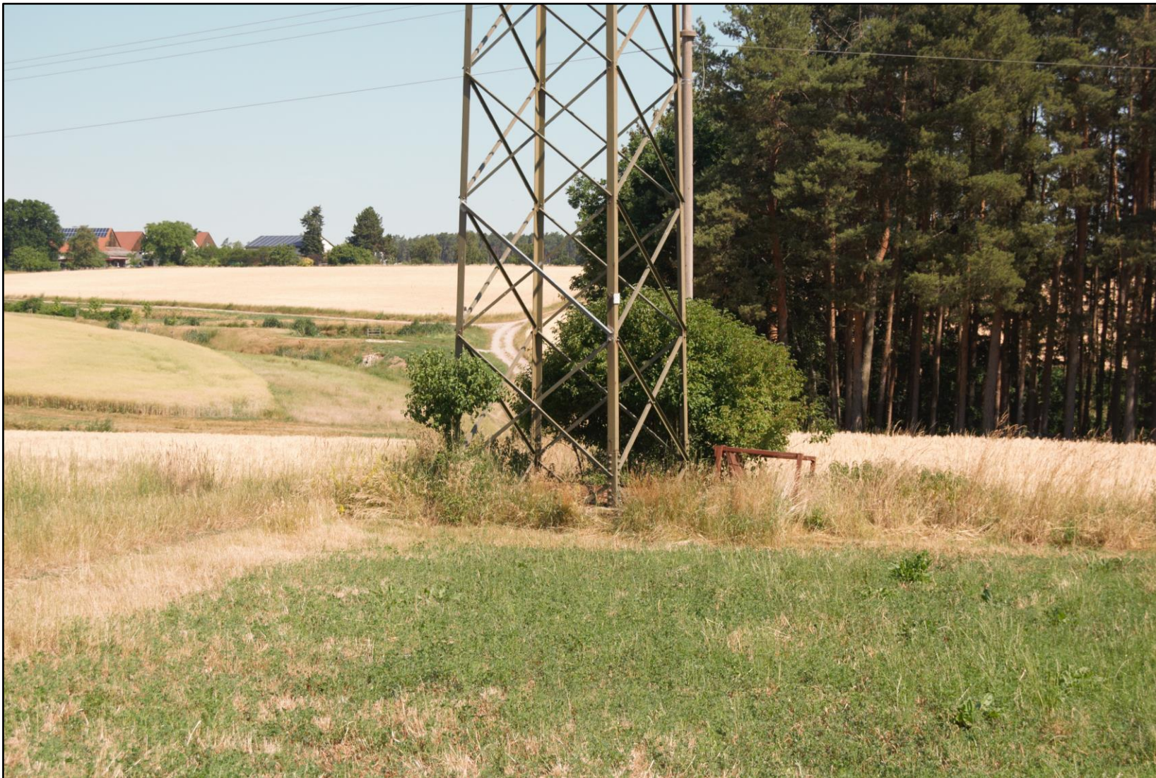
Abbildung 14: Mast Nr. 351 (Mastfuß)
