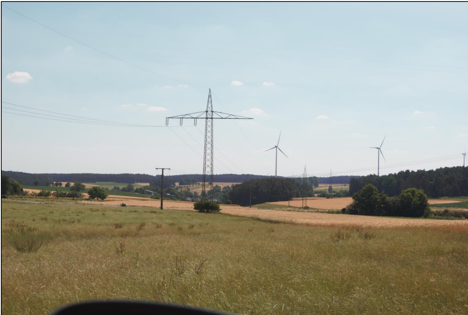
Abbildung 16: Mast Nr. 353 (gegen Leitungsrichtung)
