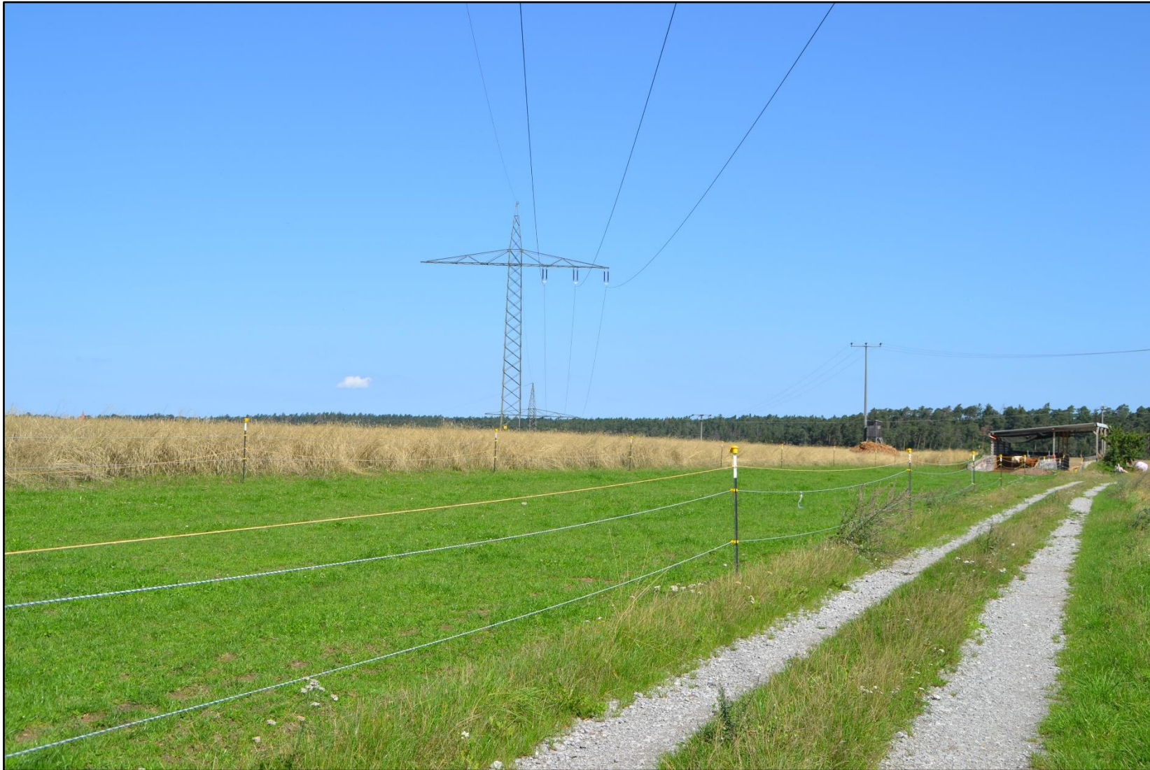
Abbildung 53: Mast Nr. 390 (in Leitungsrichtung)
