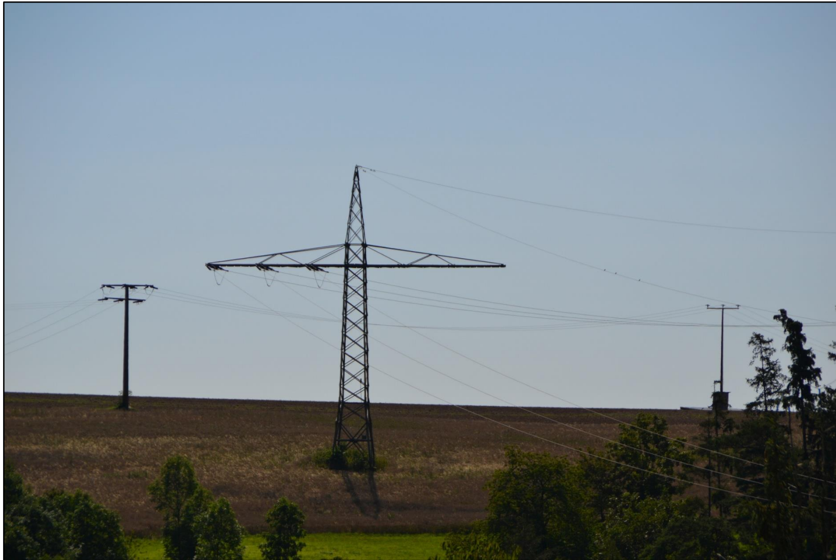
Abbildung 54: Mast Nr. 391 (gegen Leitungsrichtung)
