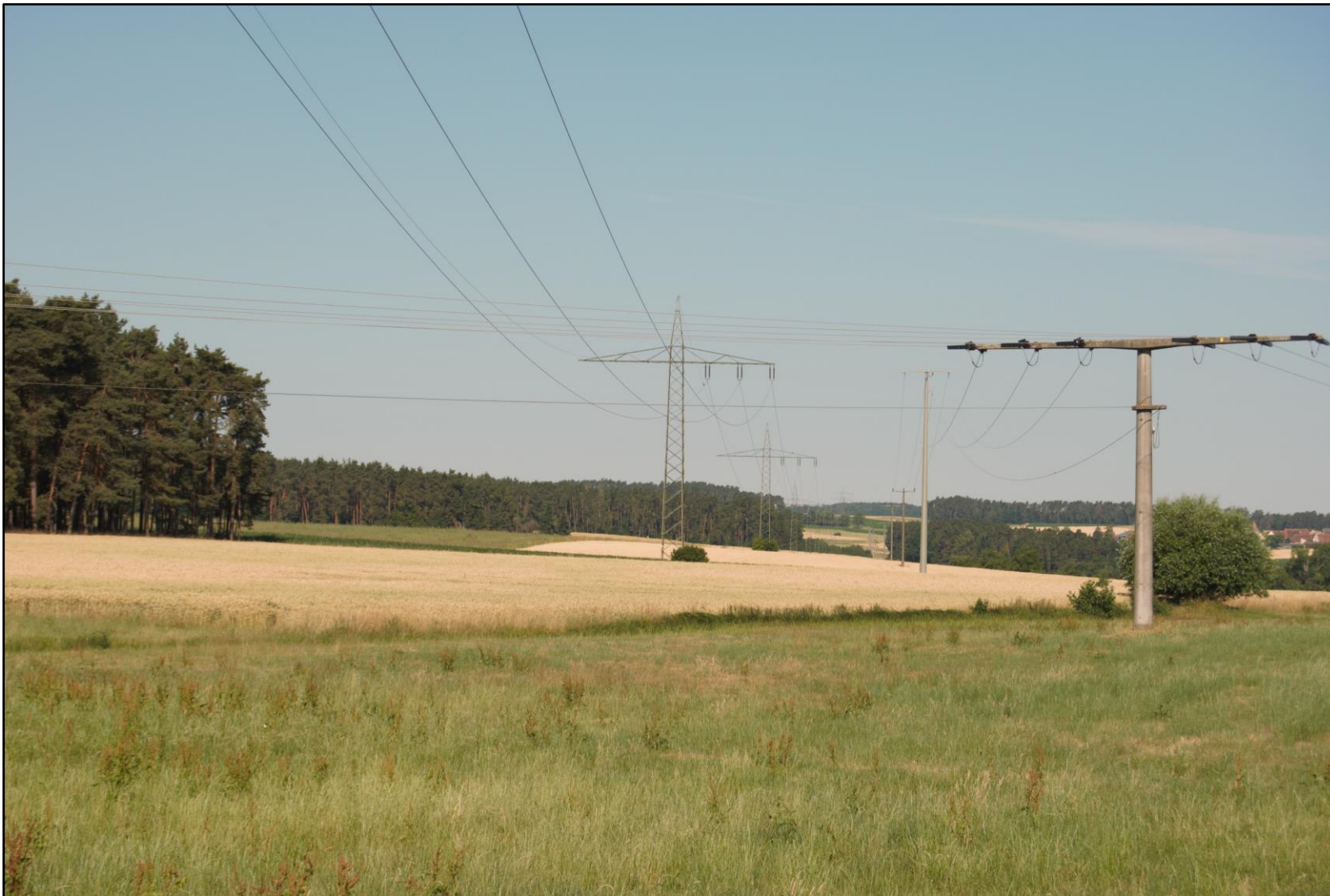
Abbildung 8: Mast Nr. 345 (in Leitungsrichtung)
