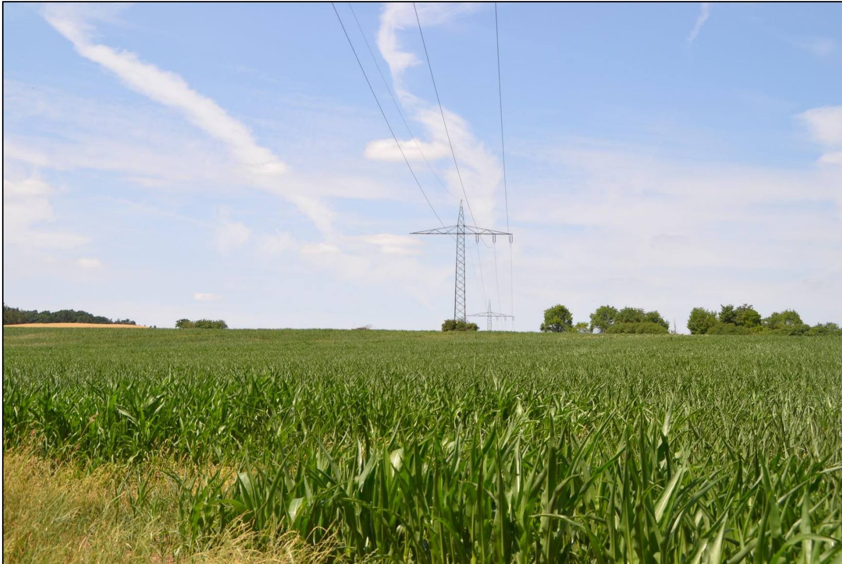
Abbildung 34: Mast Nr. 371 (in Leitungsrichtung)
