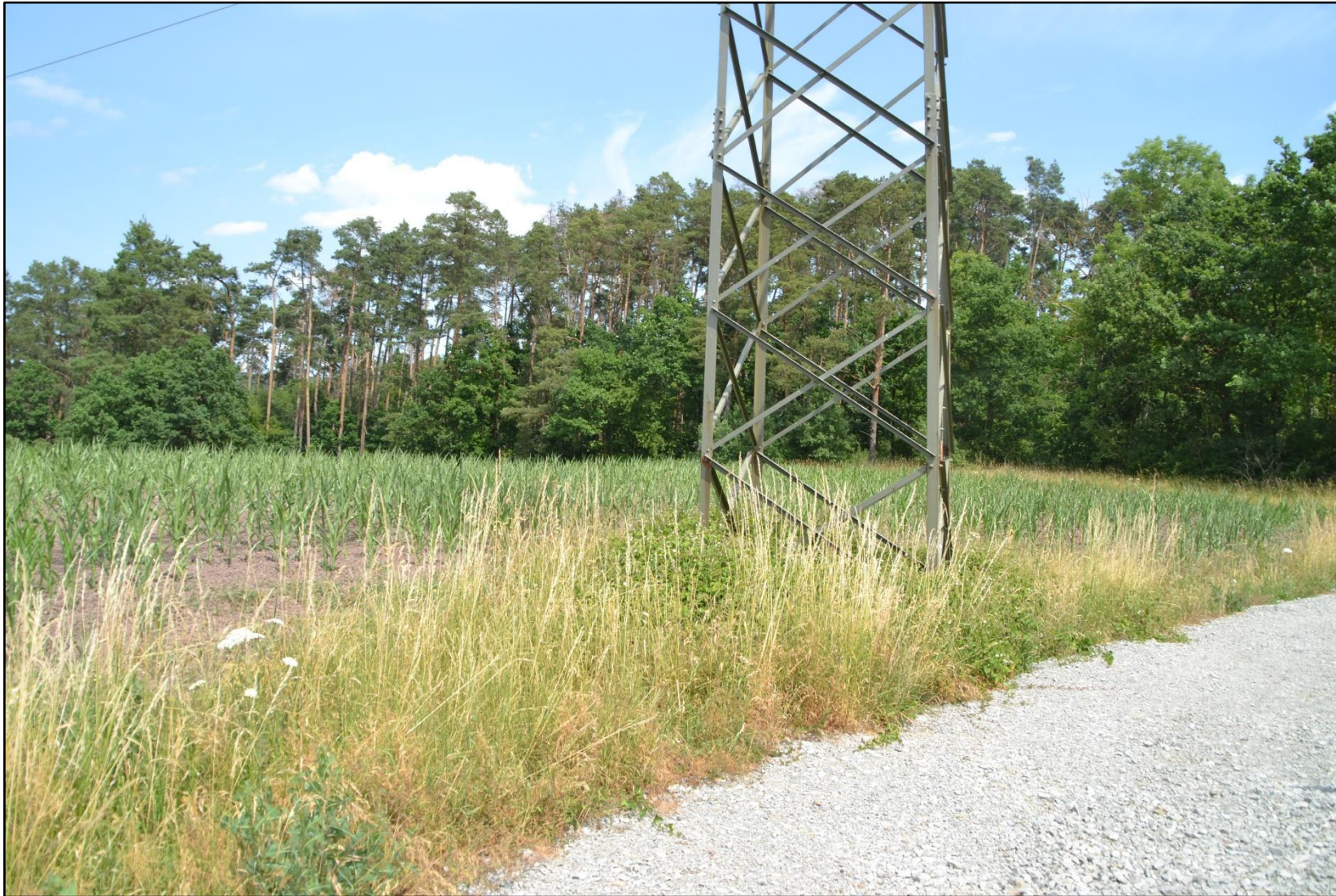
Abbildung 42: Mast Nr. 379 (Mastfuß)
