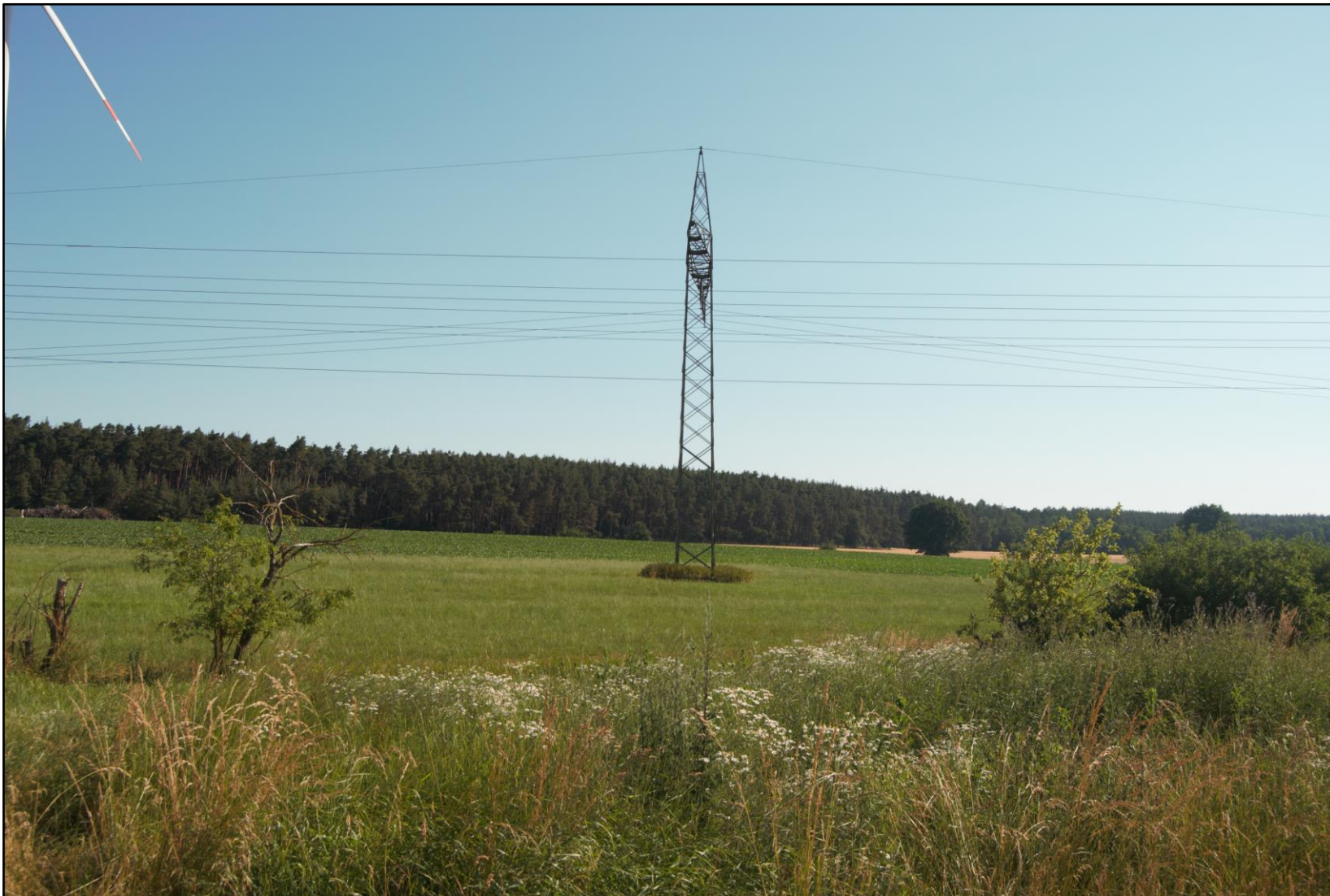
Abbildung 2: Mast Nr. 339 (seitlich)
