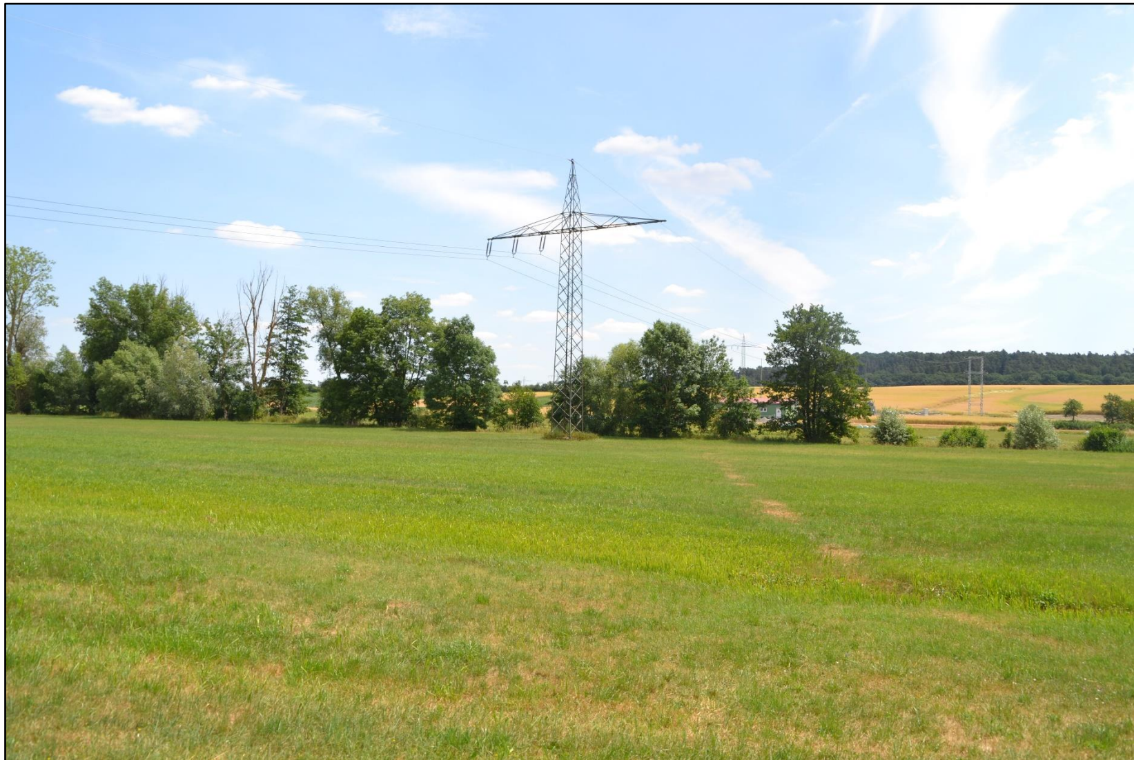
Abbildung 40: Mast Nr. 377 (gegen Leitungsrichtung)
