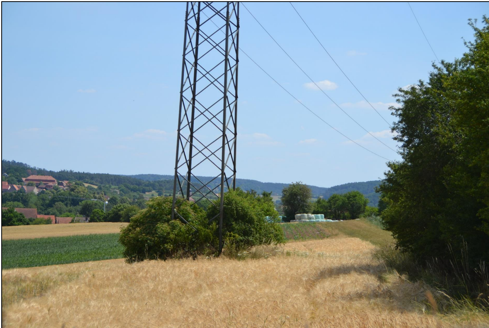
Abbildung 35: Mast Nr. 372 (Mastfuß)
