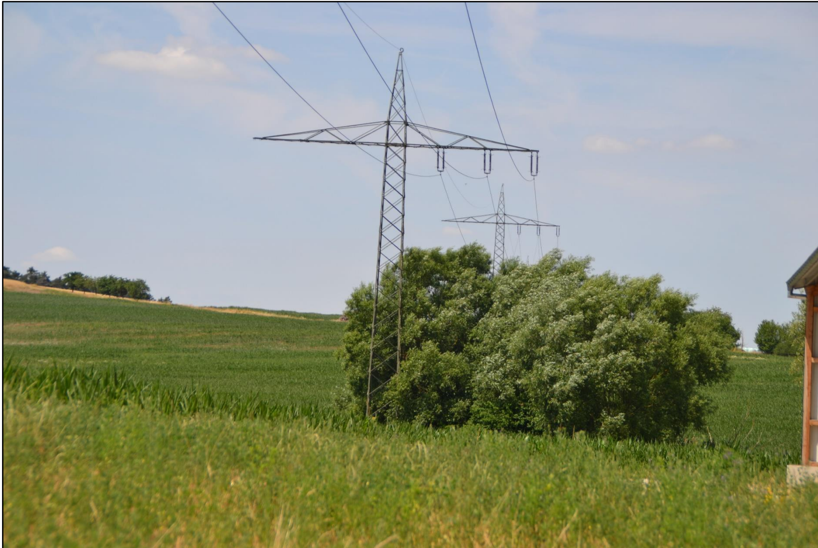
Abbildung 33: Mast Nr. 370 (in Leitungsrichtung)
