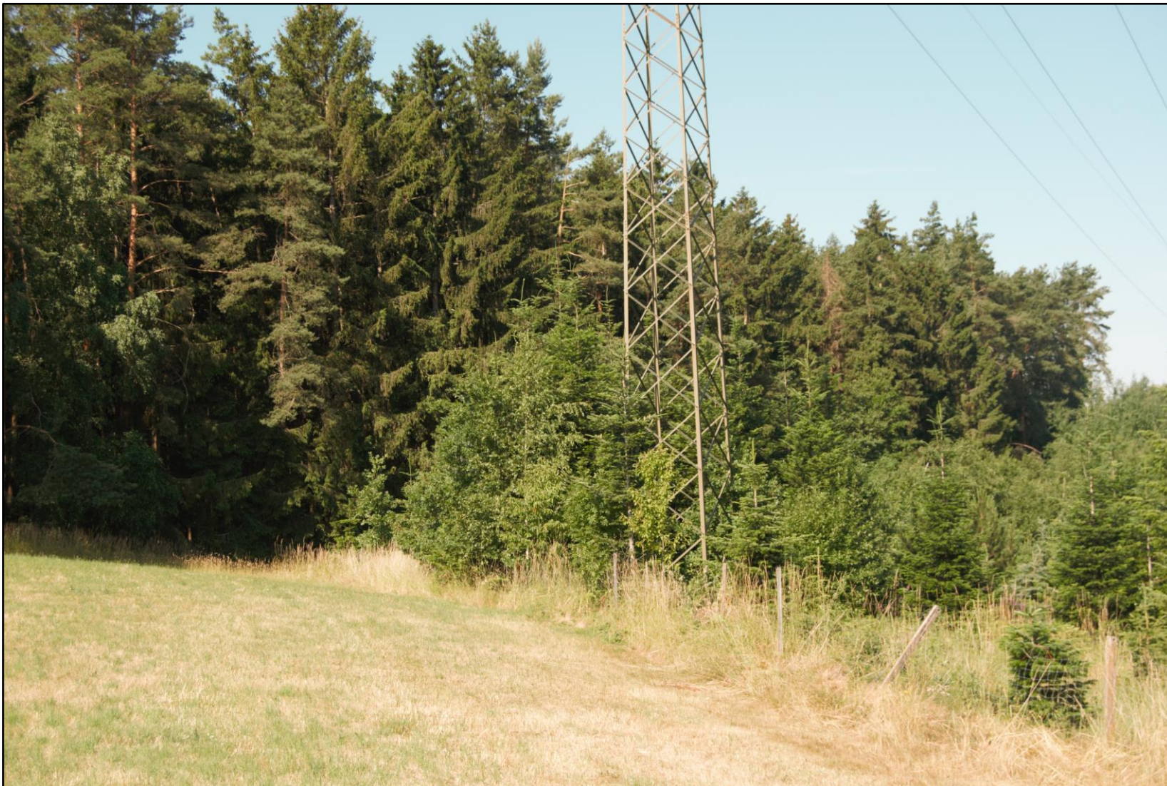
Abbildung 13: Mast Nr. 350 (Mastfuß)
