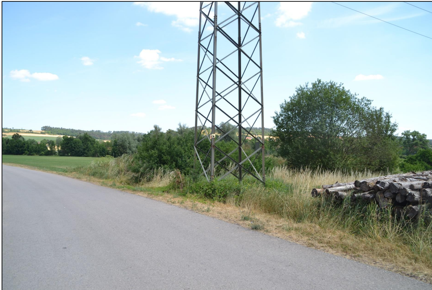
Abbildung 31: Mast Nr. 368 (Mastfuß)
