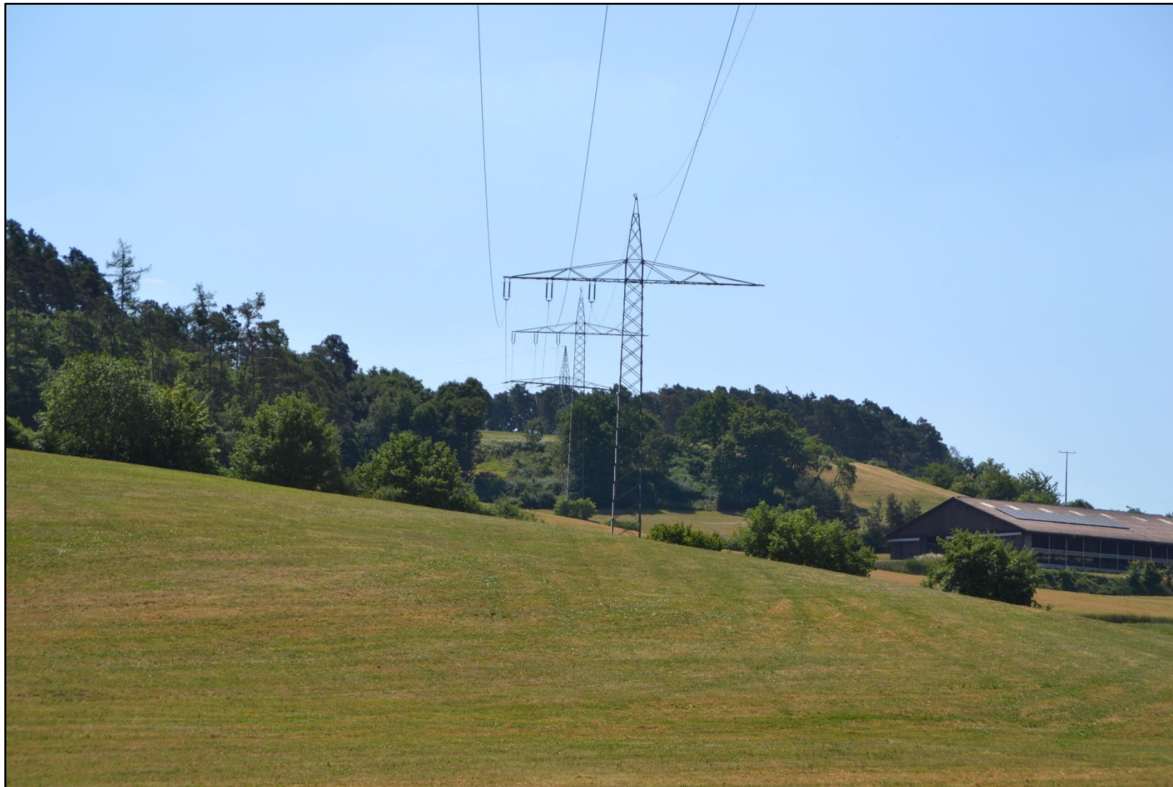
Abbildung 21: Mast Nr. 358 (gegen Leitungsrichtung)
