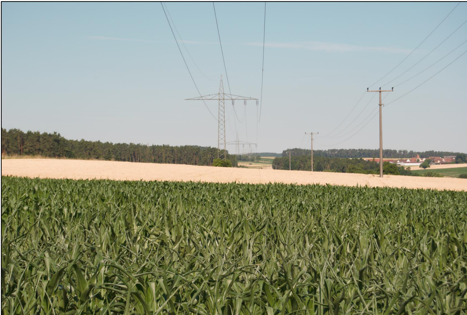
Abbildung 9: Mast Nr. 346 (in Leitungsrichtung)
