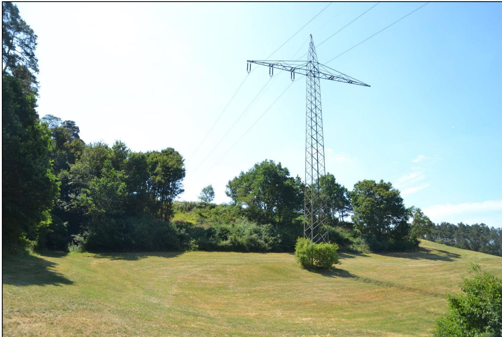
Abbildung 20: Mast Nr. 357 (gegen Leitungsrichtung)
