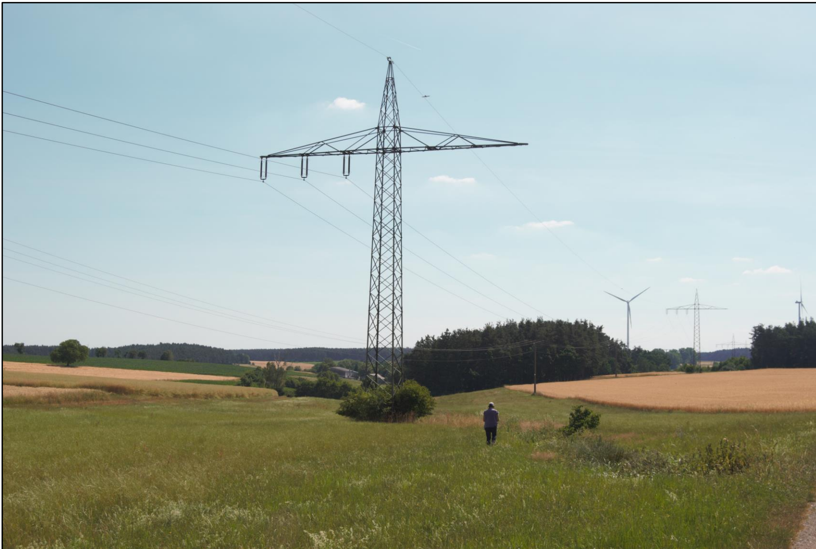
Abbildung 15: Mast Nr. 352 (gegen Leitungsrichtung)
