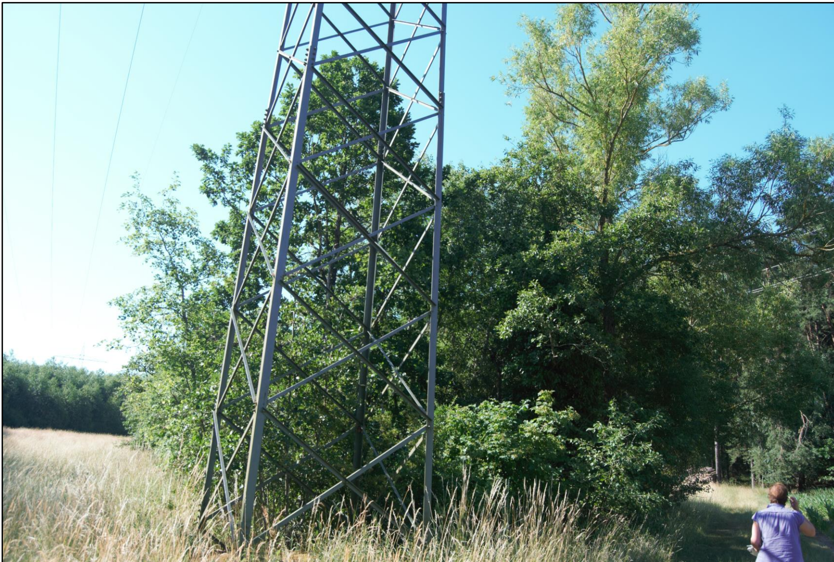
Abbildung 6: Mast Nr. 343 (Mastfuß)
