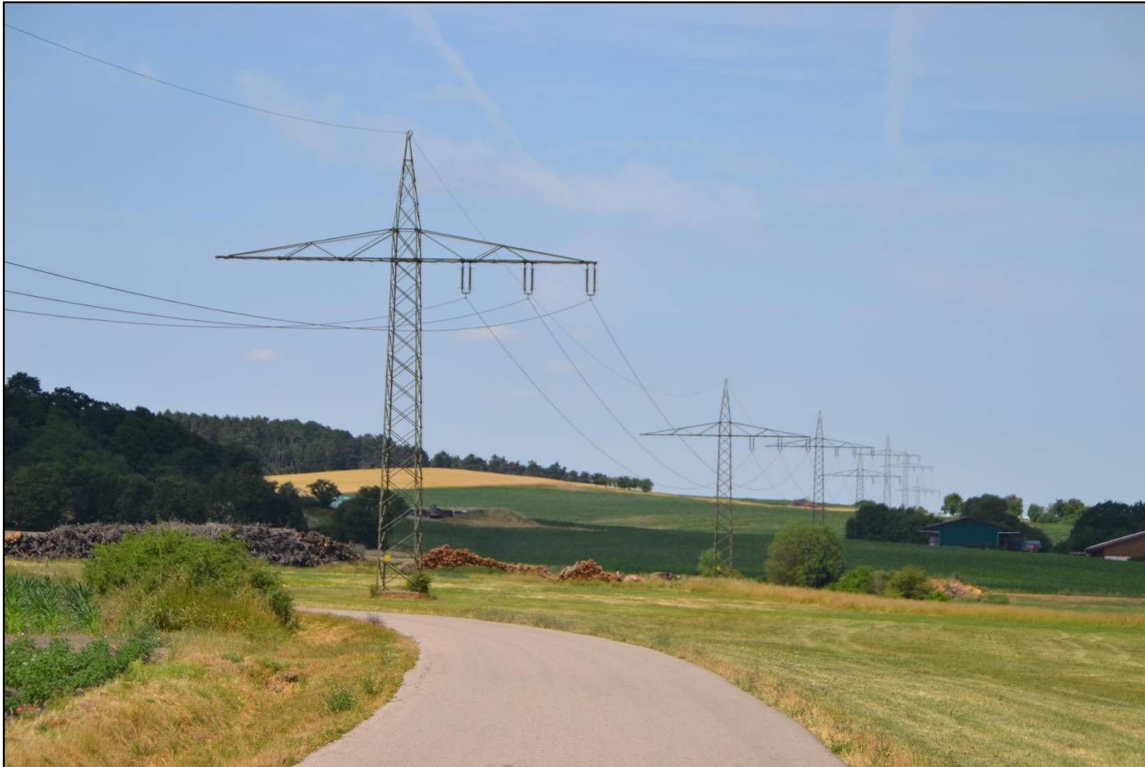
Abbildung 30: Mast Nr. 367 (in Leitungsrichtung)
