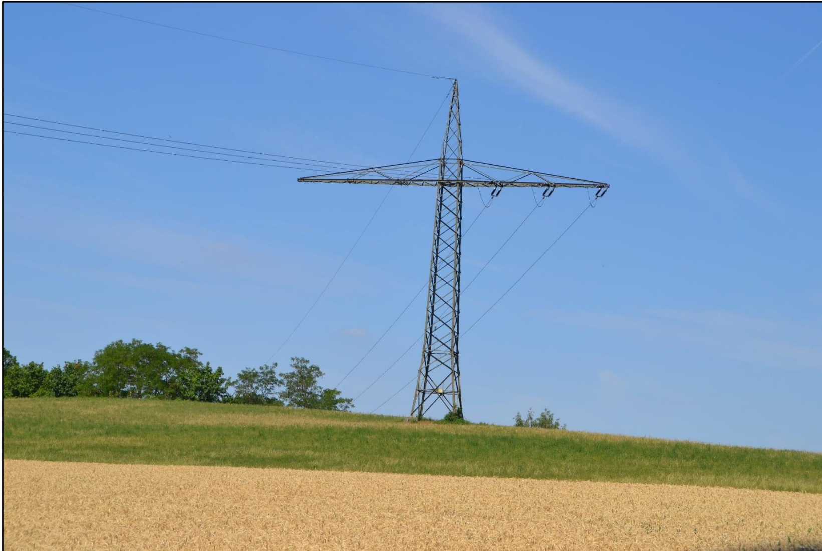
Abbildung 26: Mast Nr. 363 (in Leitungsrichtung)
