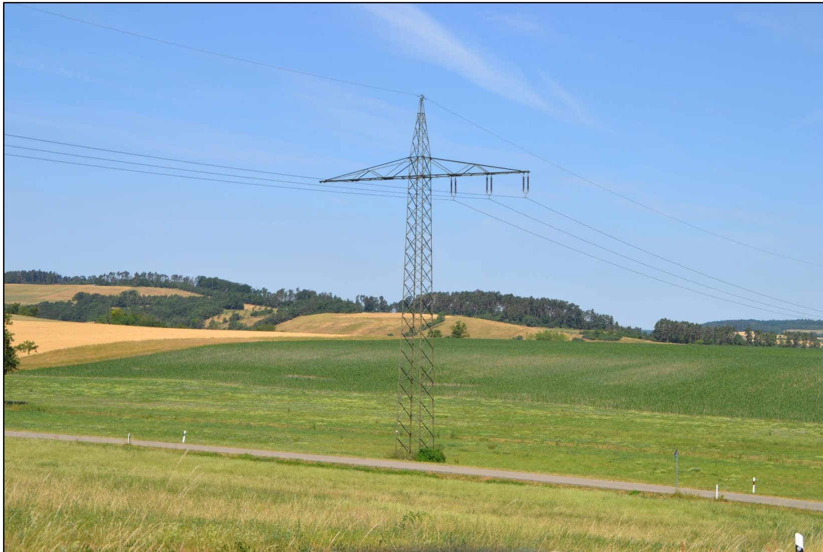
Abbildung 23: Mast Nr. 360 (in Leitungsrichtung)
