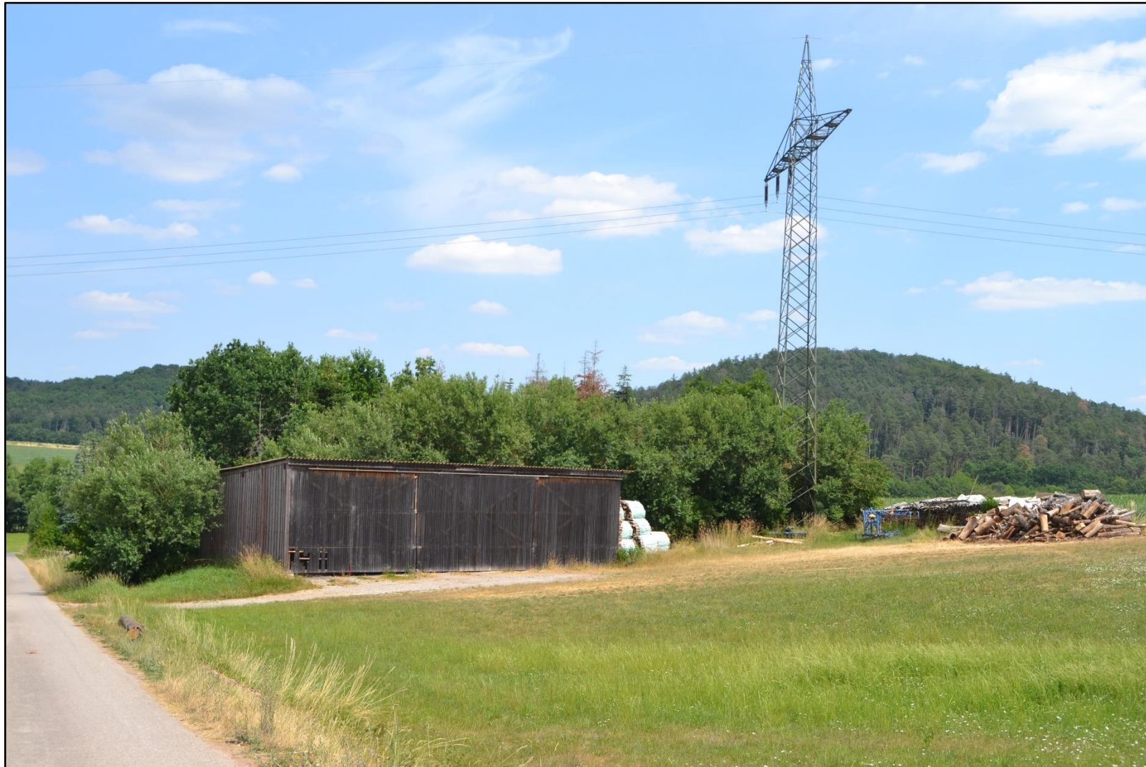
Abbildung 44: Mast Nr. 381 (seitlich)
