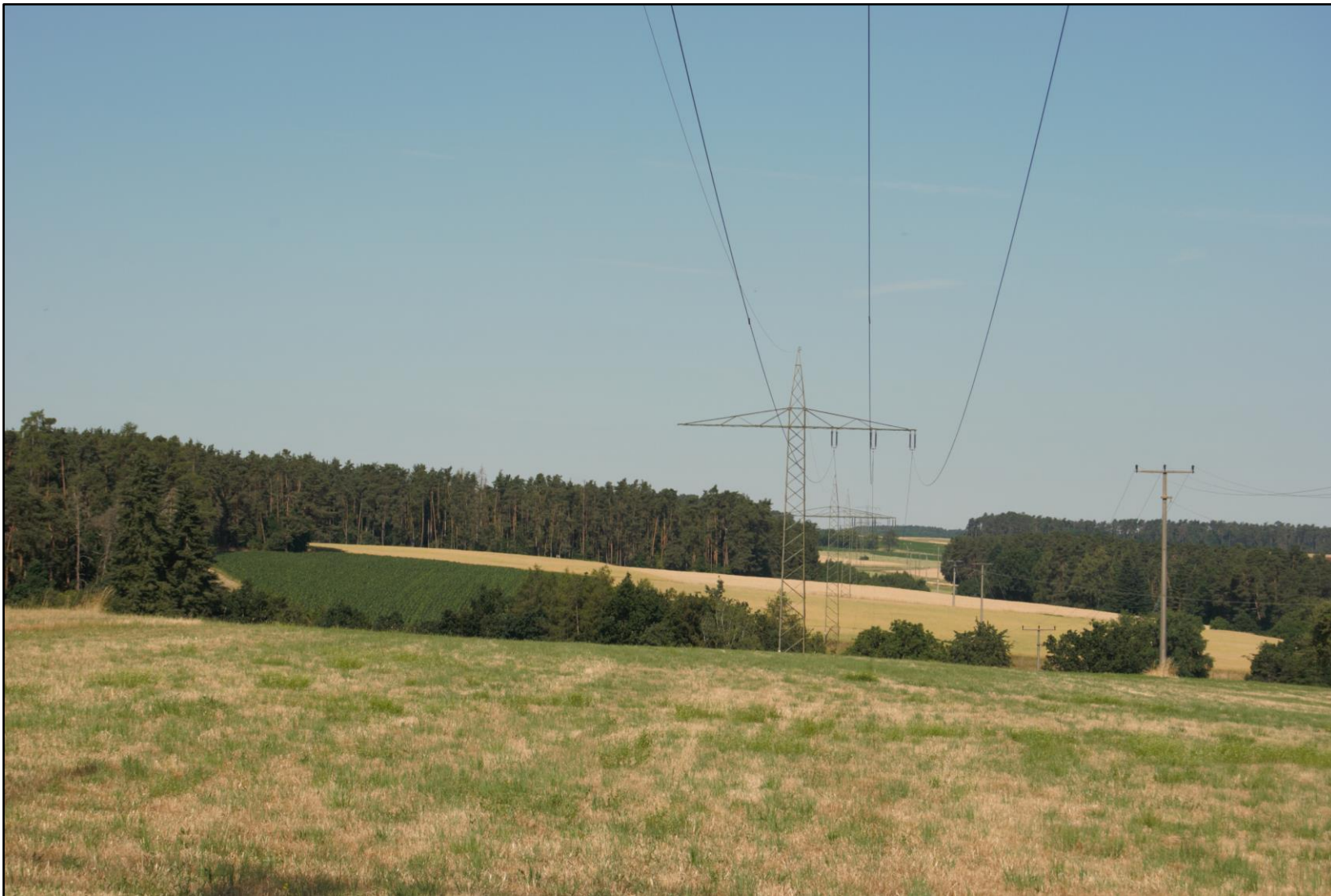
Abbildung 10: Mast Nr. 347 (in Leitungsrichtung)
