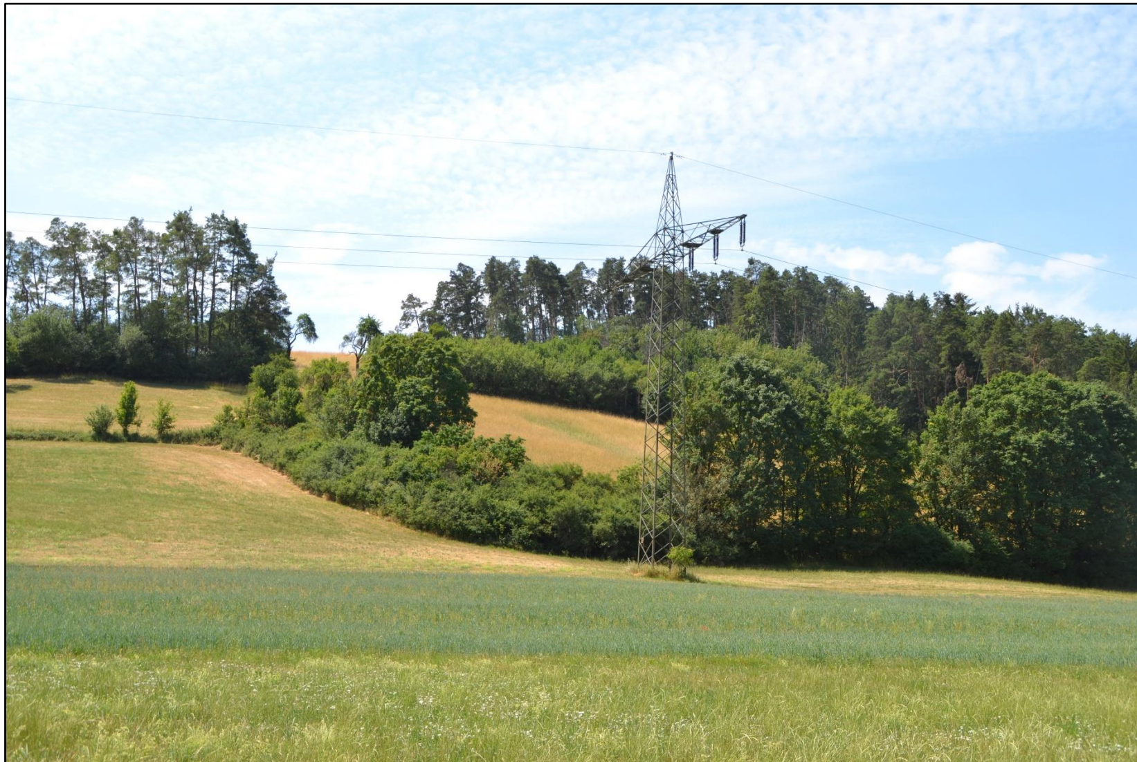
Abbildung 28: Mast Nr. 365 (seitlich)
