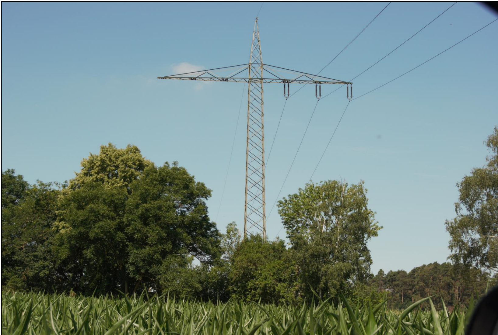
Abbildung 17: Mast Nr. 354 (in Leitungsrichtung)
