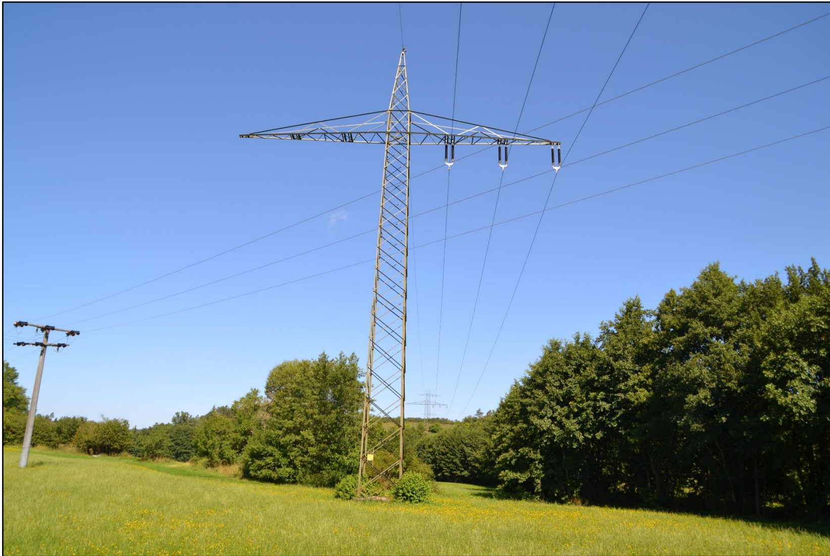
Abbildung 48: Mast Nr. 385 (in Leitungsrichtung)
