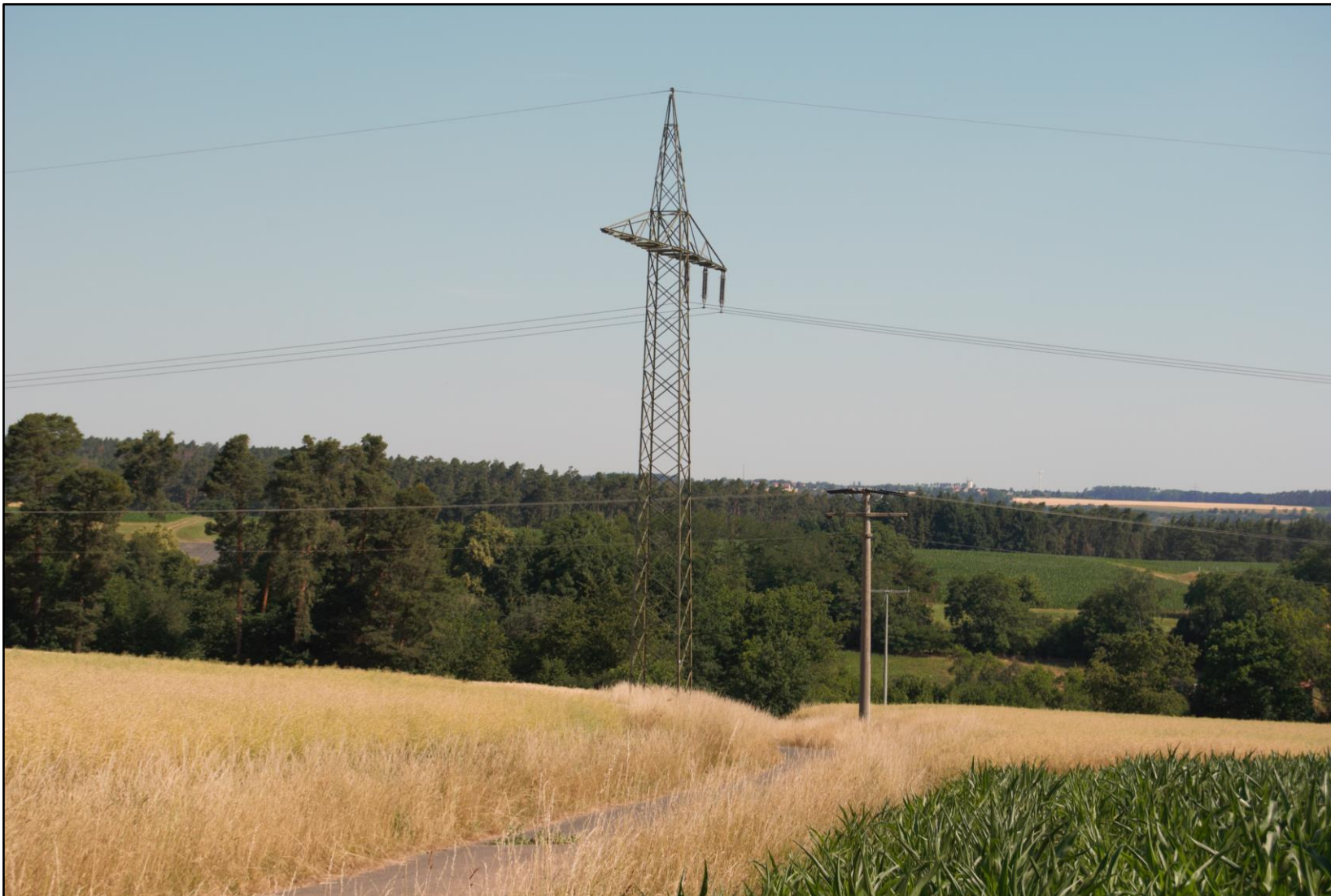
Abbildung 12: Mast Nr. 349 (seitlich)
