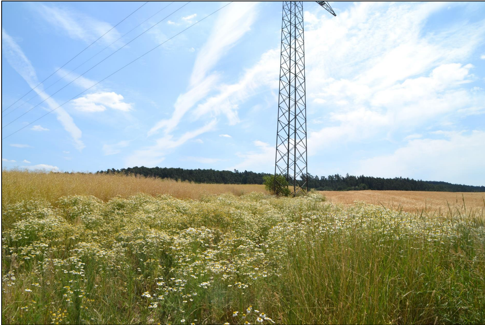
Abbildung 38: Mast Nr. 375 (Mastfuß)
