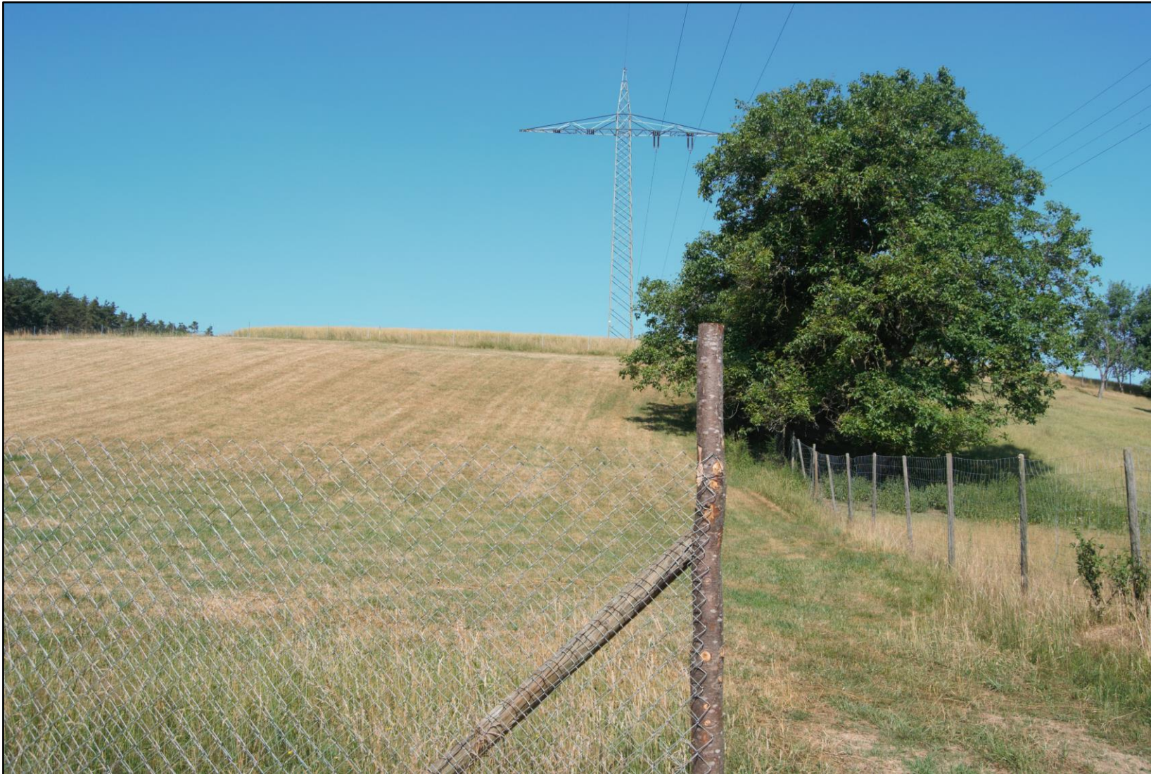
Abbildung 11: Mast Nr. 348 (in Leitungsrichtung)
