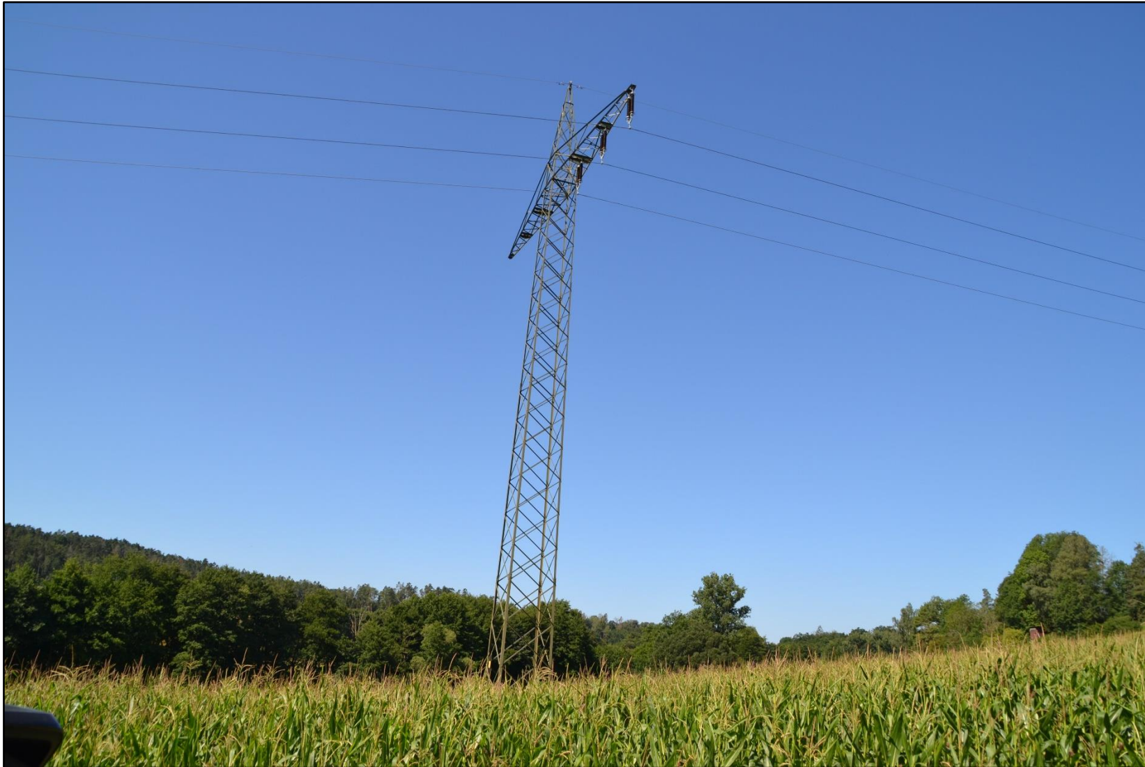
Abbildung 49: Mast Nr. 386 (in Leitungsrichtung)
