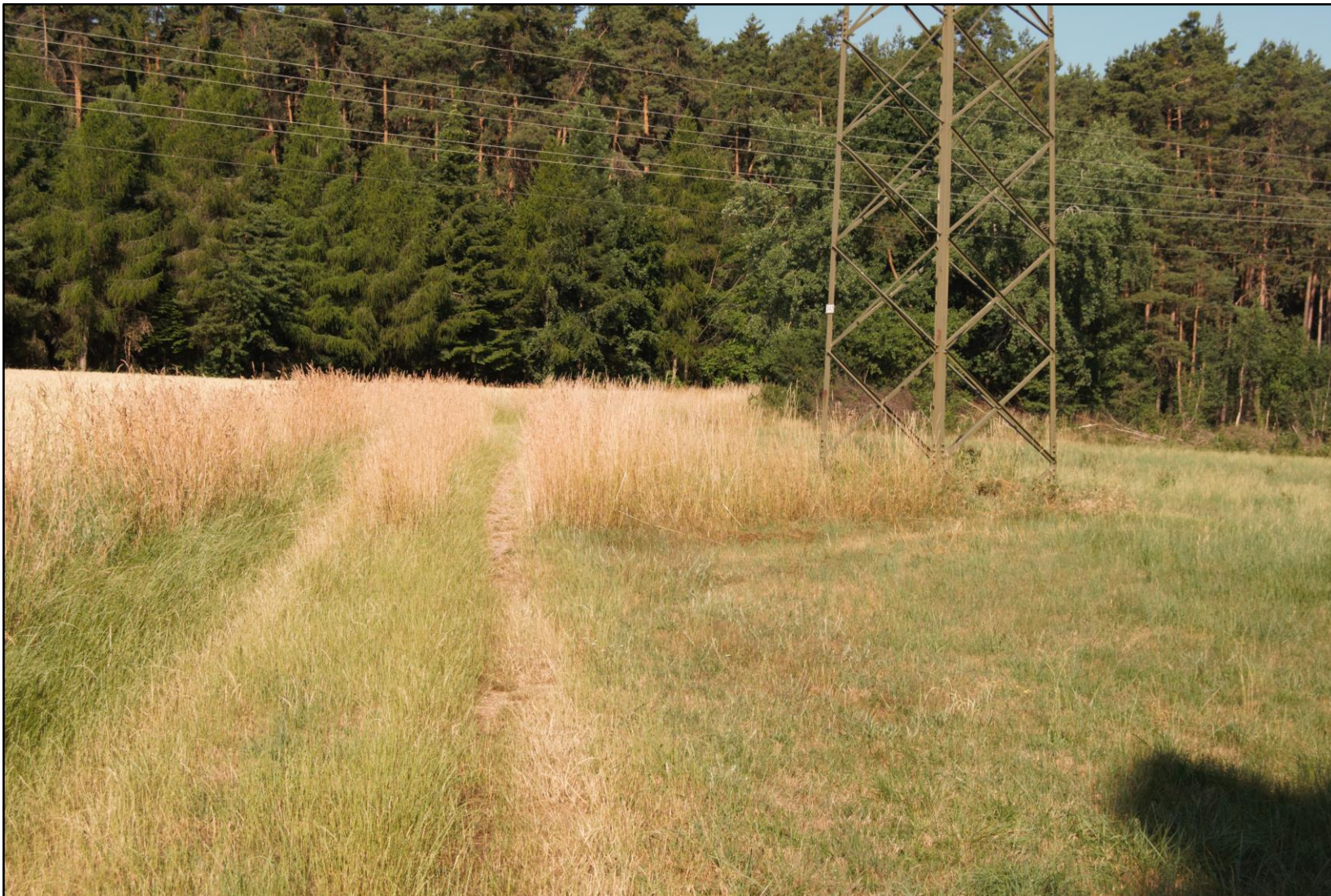
Abbildung 5: Mast Nr. 342 (Mastfuß)
