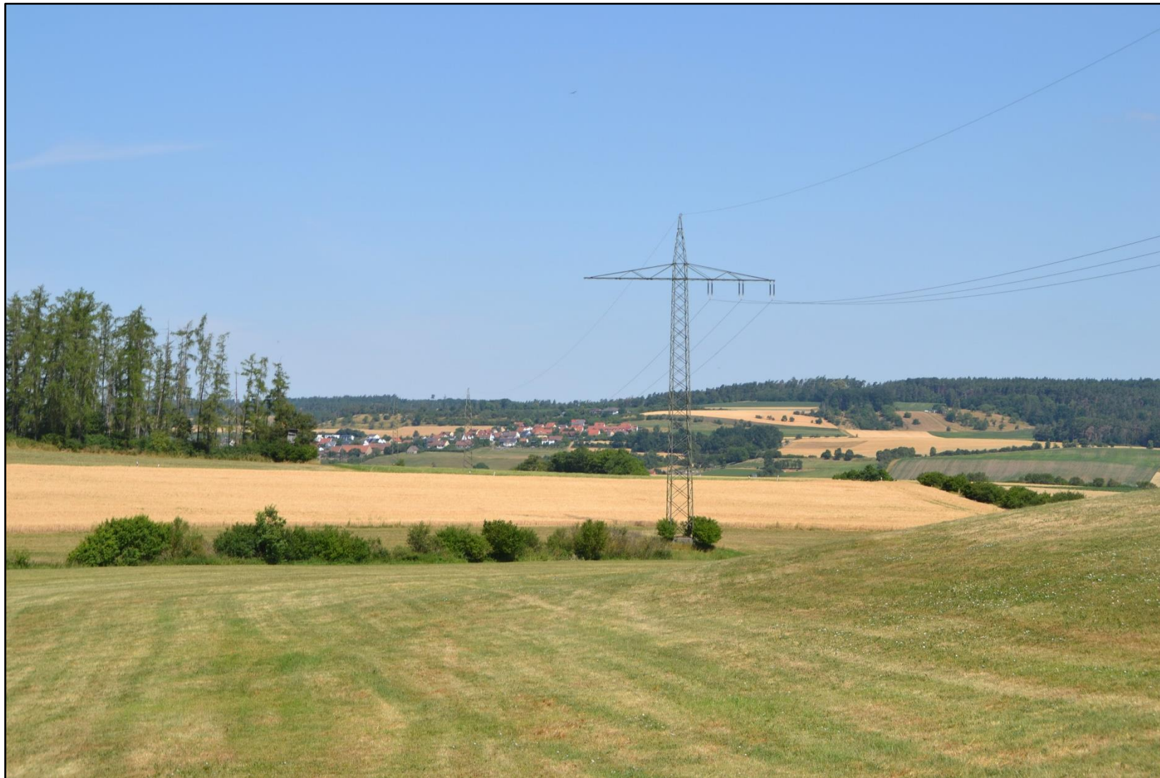
Abbildung 22: Mast Nr. 359 (in Leitungsrichtung)
