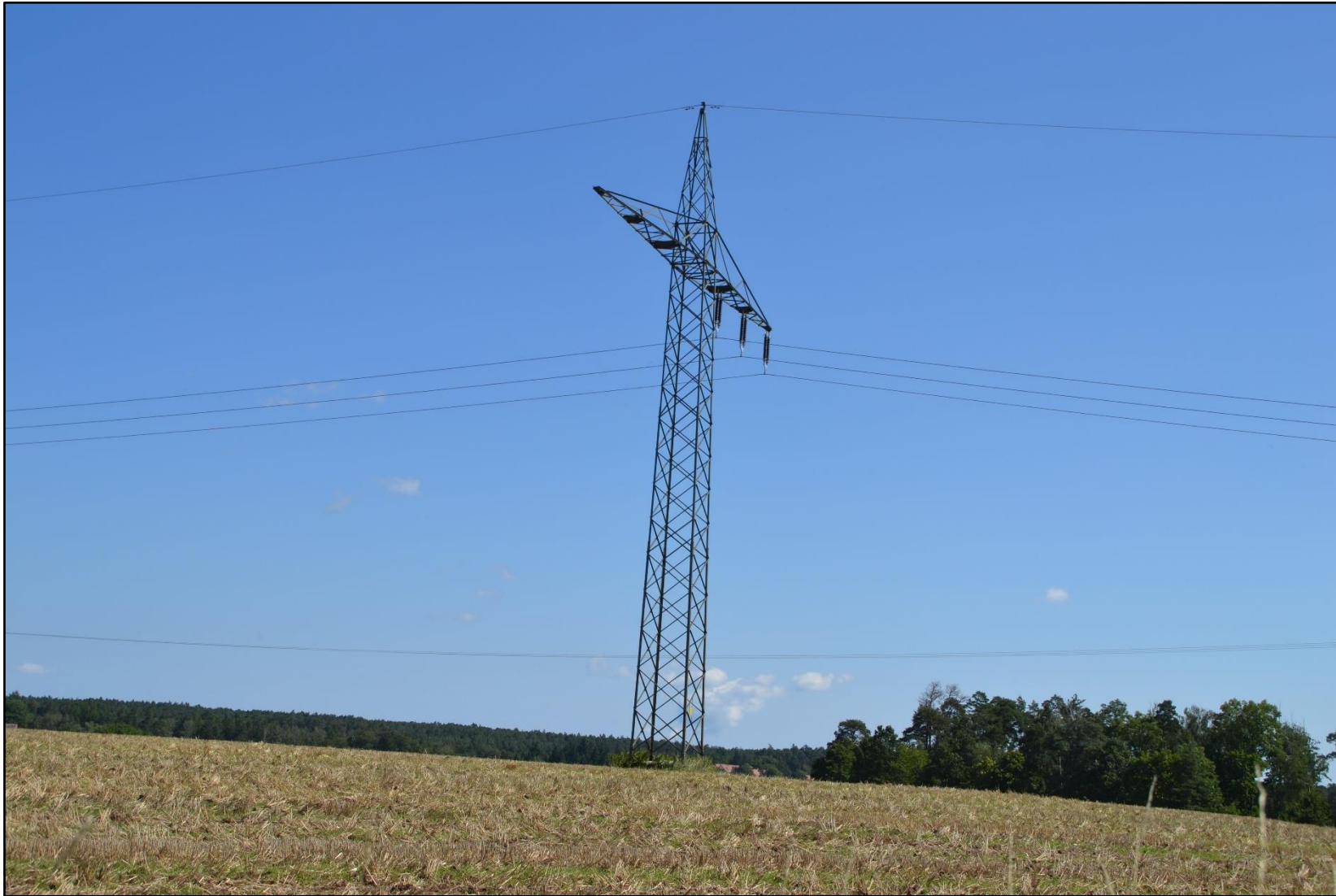
Abbildung 51: Mast Nr. 388 (seitlich)
