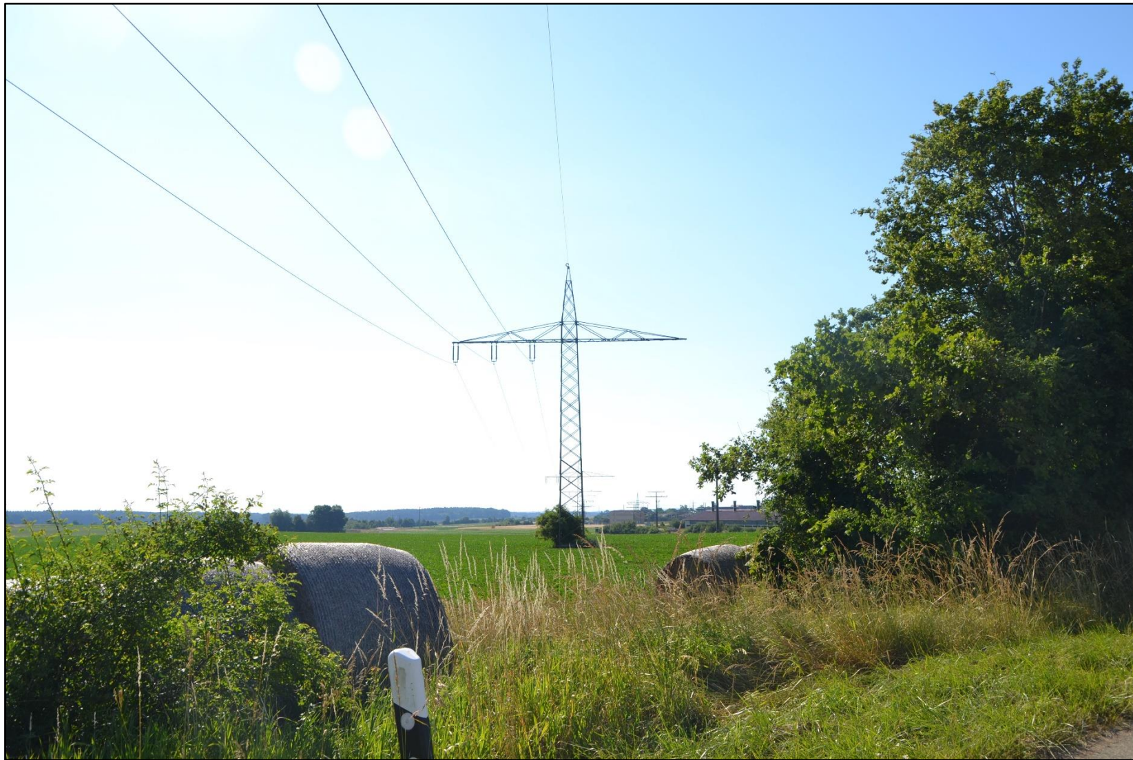
Abbildung 3: Mast Nr. 340 (gegen Leitungsrichtung)
