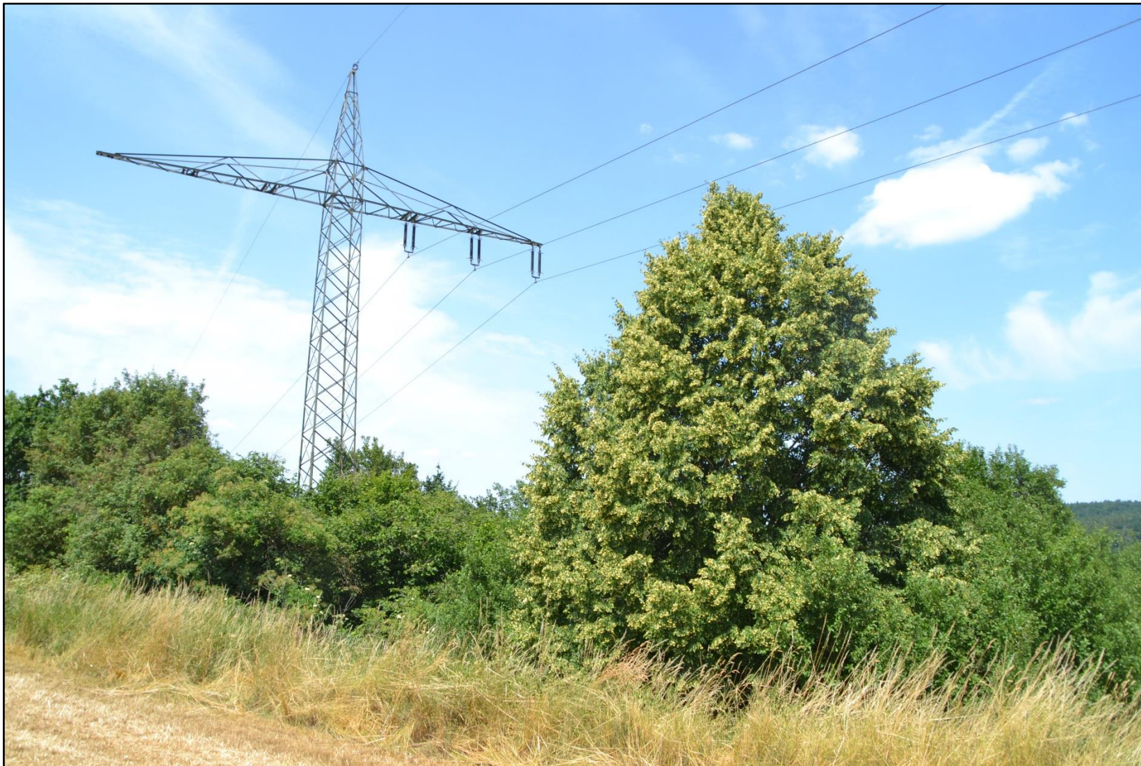
Abbildung 36: Mast Nr. 373 (in Leitungsrichtung)
