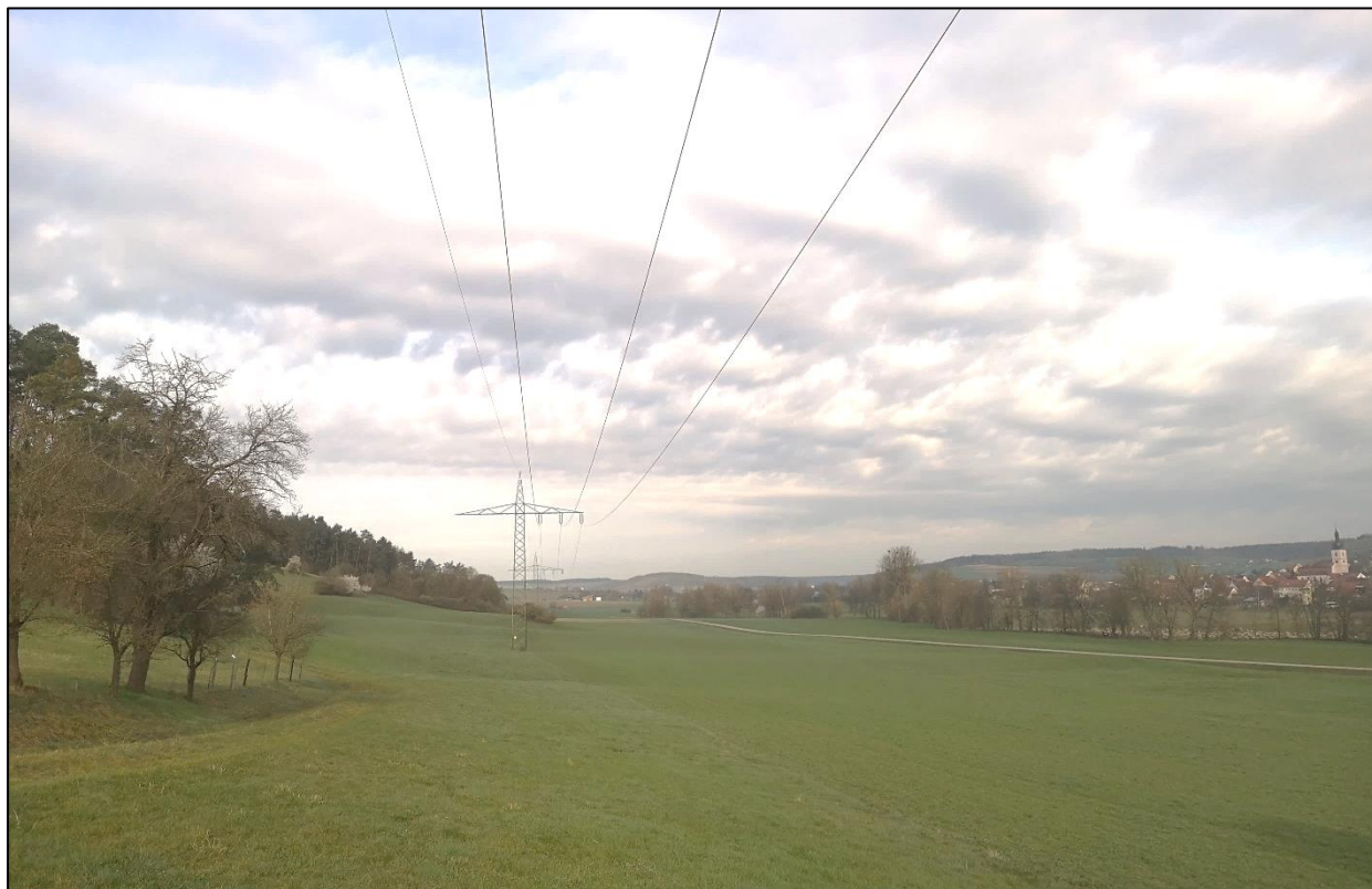
Abbildung 2: Leitungsverlauf im Taleinschnitt der Zenn (Eigene Aufnahme)
