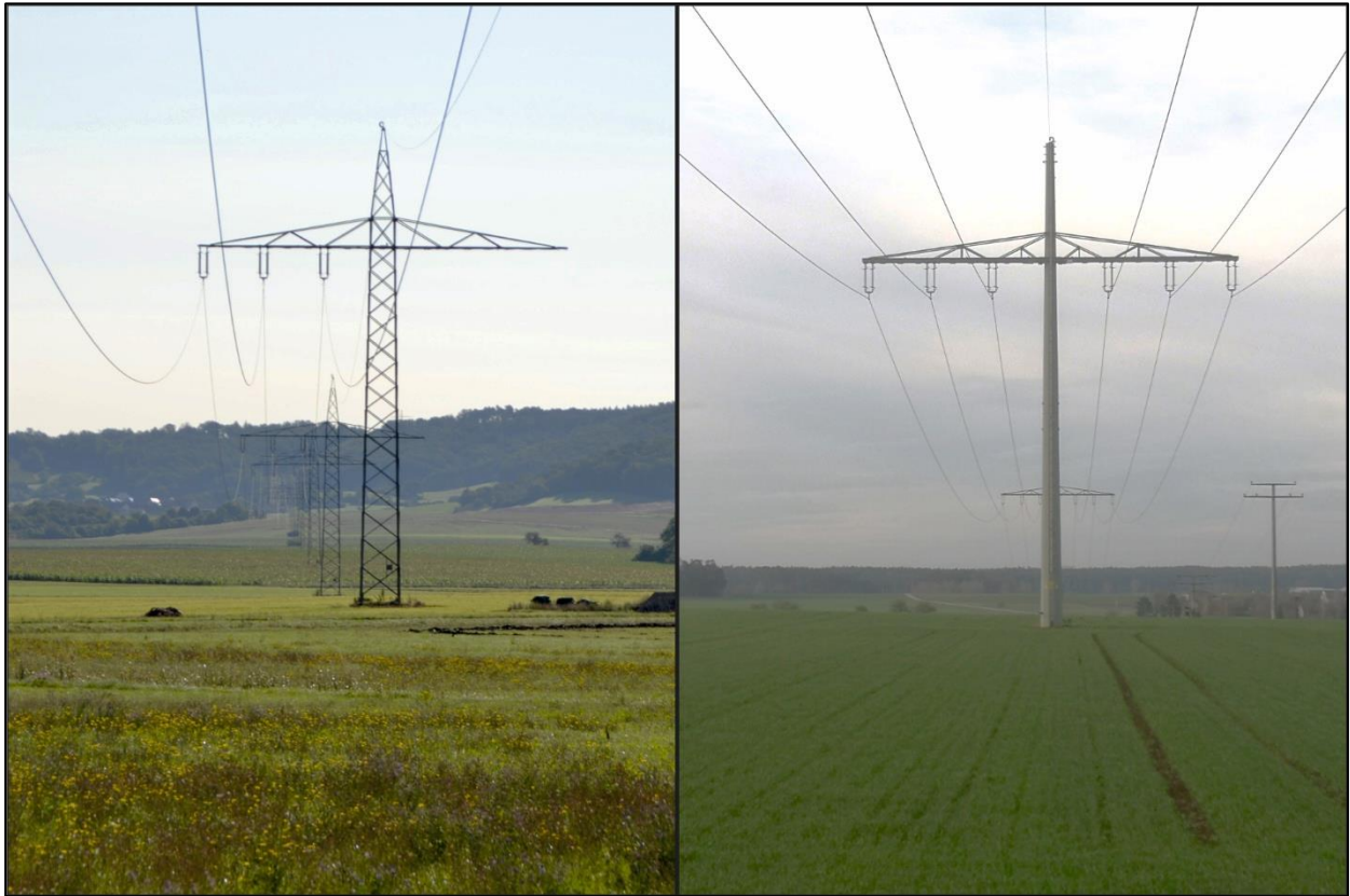
Abbildung 3: Vergleich Gittermast (Bestand) vs. Stahlvollwandmast (Planung)
