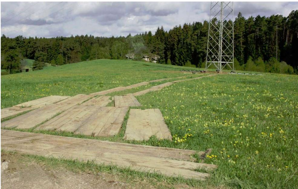
Abbildung 5: Bsp. Zuwegung über Holzplatten
