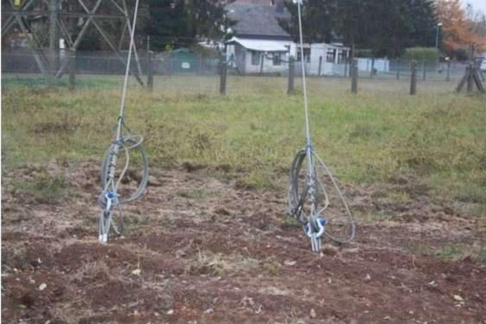
Abbildung 6: Bsp. im Boden eingebrachte Abankerungen
