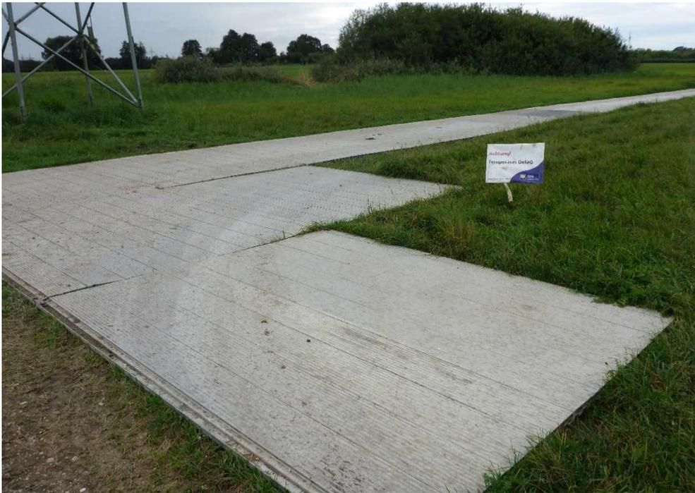
Abbildung 4: Bsp. Zuwegung über Aluplatten
