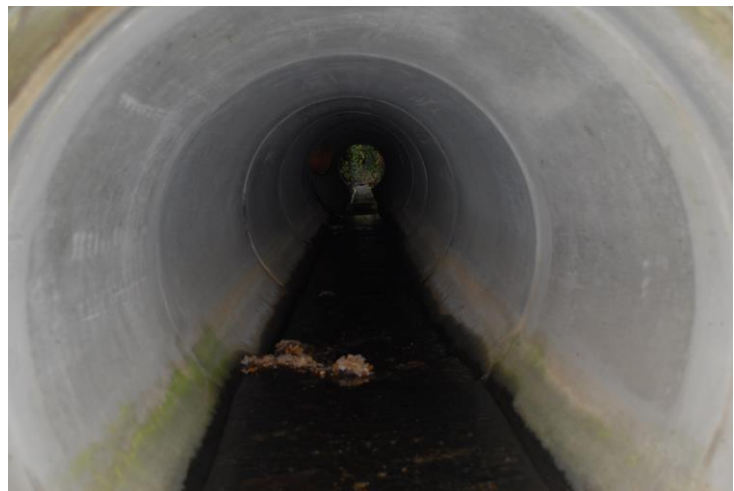
Durchlass des Entengrabens (Betonrohr, ohne trockene Berme)
