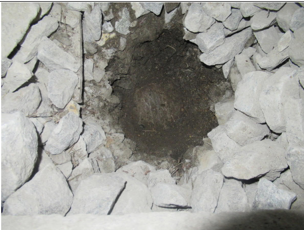
Bild 4: Detailfoto S 4, 0,0 – 0,5 m u. Schwellen OK, Beton ohne bituminöse Feuchtigkeitssperre
