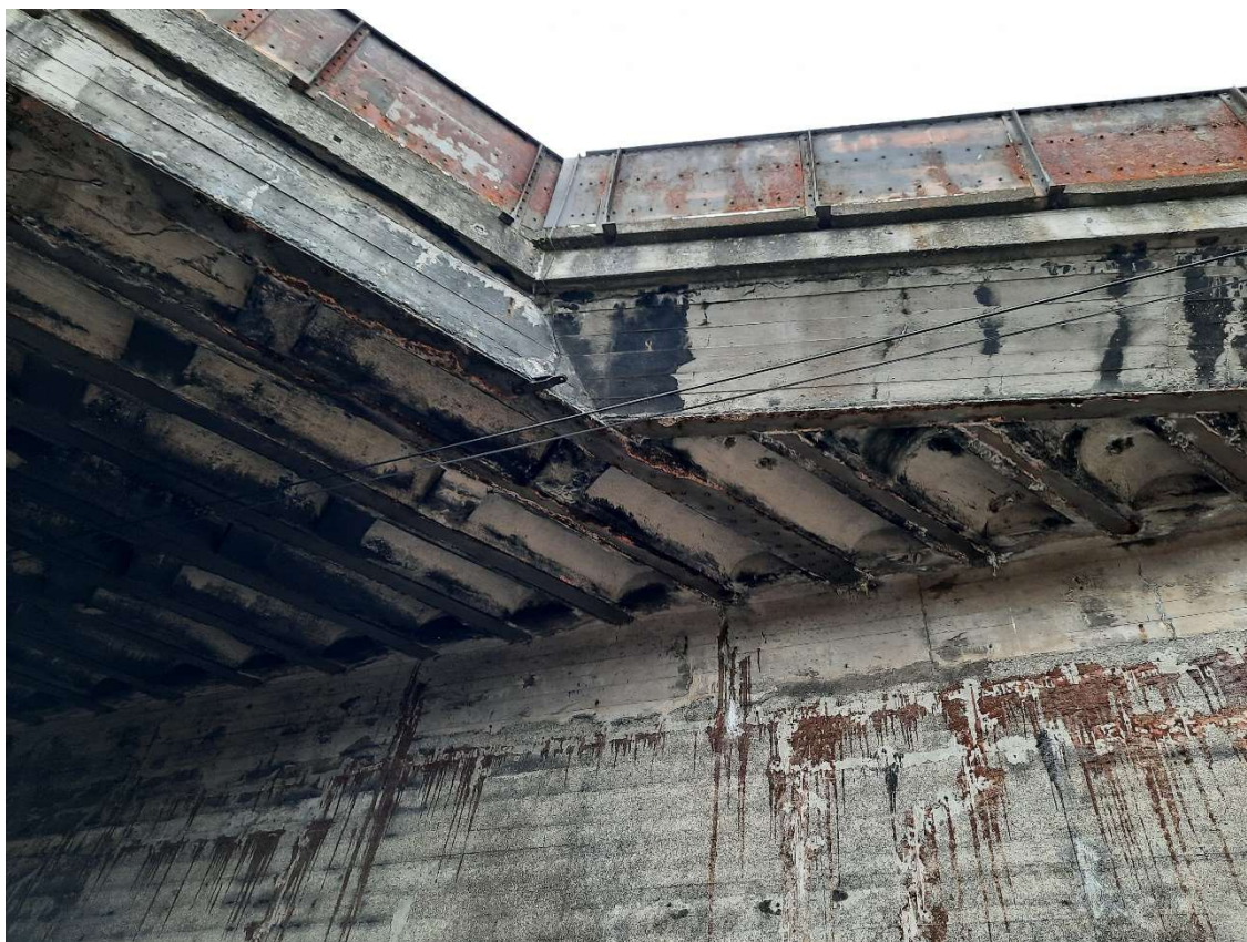
Abbildung 3: Überbau Überwerfungsbauwerk WIB mit Spargewölbe, Nordseite
