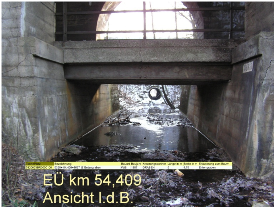
Abb. 2: EÜ Entengraben mit Blick in Richtung Osten zur S-Bahnlinie mit dem Durchlass EÜ Die Strecke weist eine Bruttotonnenbelastung pro Gleis von 19,1 Mio. t auf, das entspricht einer Tagesbelastung von ca. 52.000 lt /d. Die zulässige Geschwindigkeit beträgt für Reisezüge 160 km/h und für Güterzüge 120 km/h.
