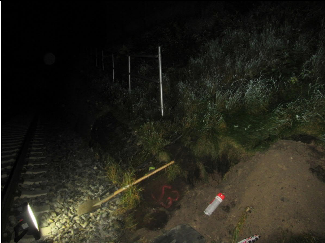
Bild 7: Übersichtsfoto Stützwand mit Handschurf S 3 zum Auffinden von Schwarzanstrich der erdberührten Bauteile
