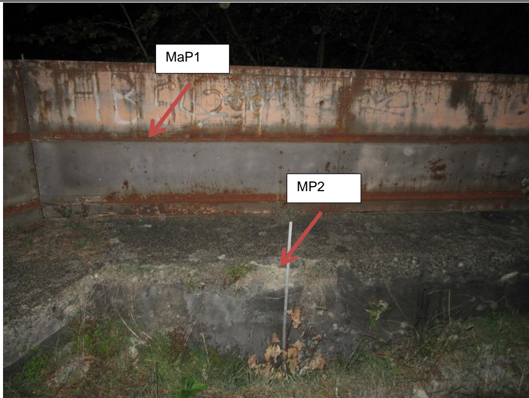
Bild 5: Übersichtsfoto Überwerfungsbauwerk mit Probenahmepunkten Korrosionsschutzanstrich (MaP1 / Lfd.-Nr. 5) und Betonabschlagprobe MP2
