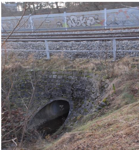
Durchlass des Entengrabens unter S-Bahn und Schallschutzwand
