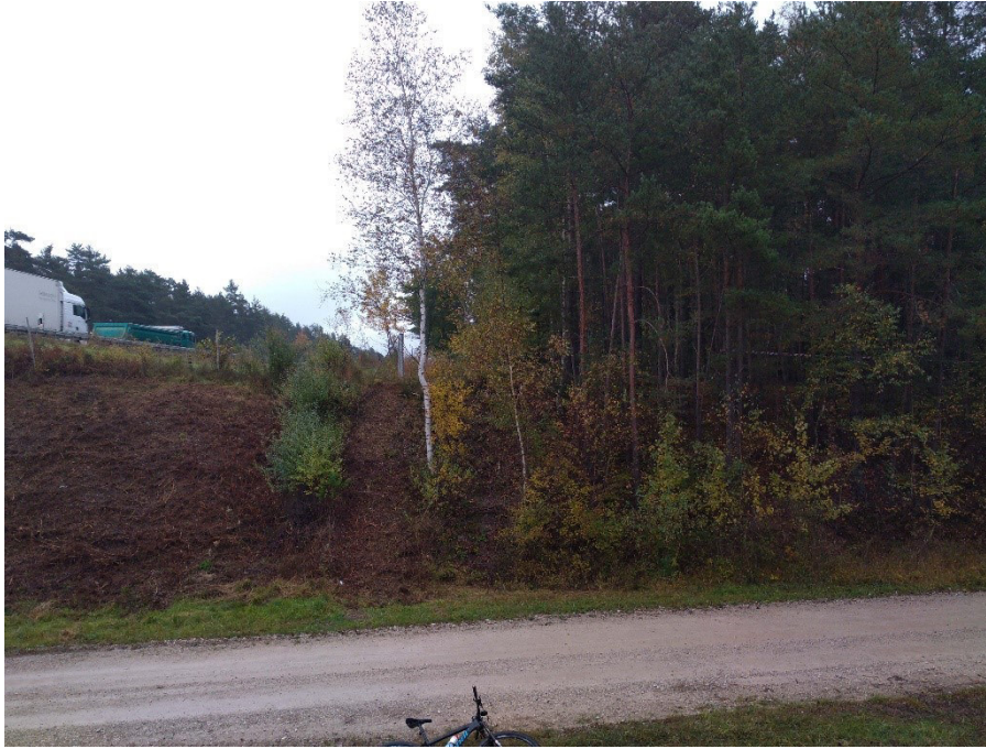
Foto 5: (F-A-05 in Anlage 1.9) Bereich Mastnummer 720-721 Blickrichtung O
