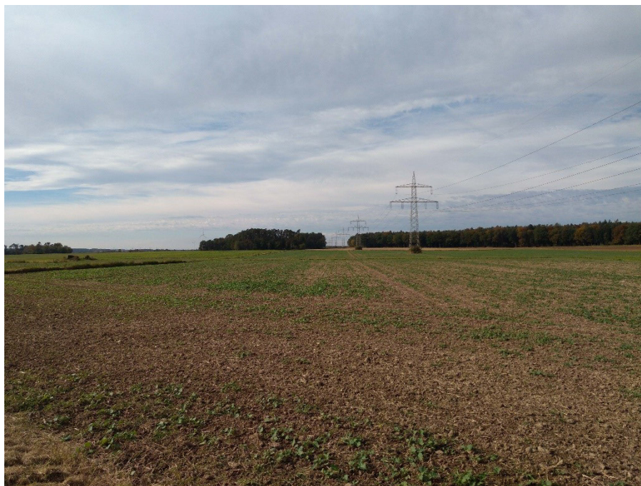
Foto 31: (F-A-31 in Anlage 1.9) Bereich Mastnummer 101 Blickrichtung W
