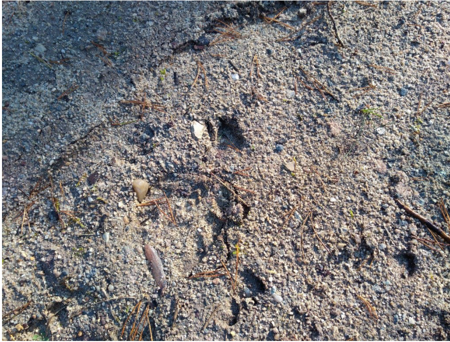
Foto 11: (F-A-11 in Anlage 1.9) Bereich Mastnummer 620 Blickrichtung OSO
