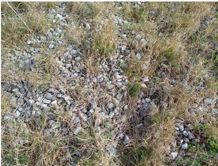
Foto 26: (F-A-26 in Anlage 1.9) Bereich Mastnummer 212-213 Blickrichtung NO
