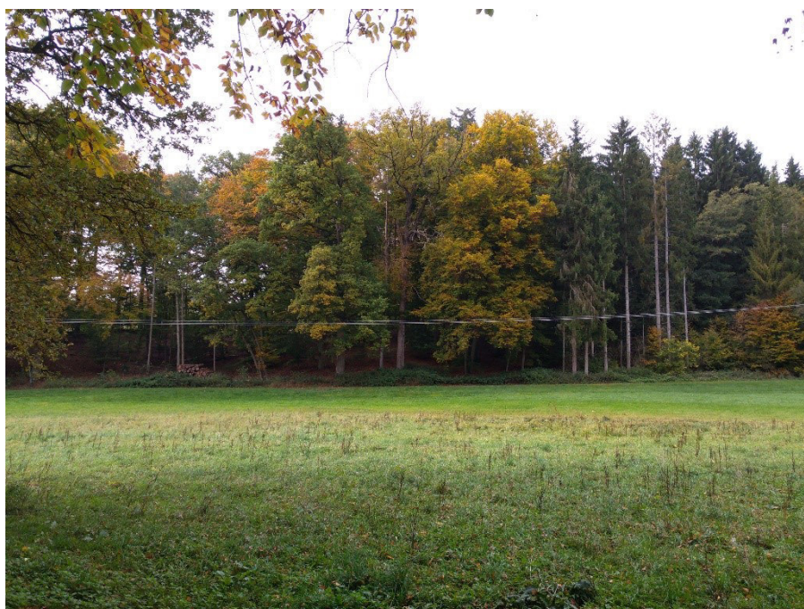
Foto 32: (F-A-32 in Anlage 1.9) Bereich Mastnummer 471 Blickrichtung NW
