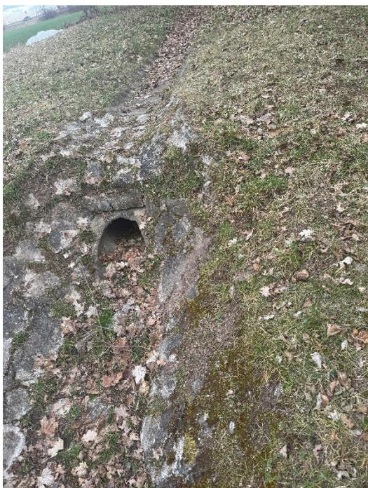
Abbildung 3: Oberflächensammler DN 400 und oberirdischer Graben (eigenes Foto)
