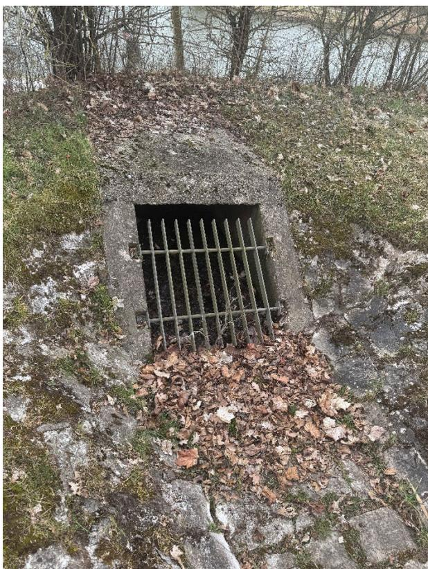
Abbildung 5: Gitter vor Schlammfang/Absetzbecken (eigenes Foto)
