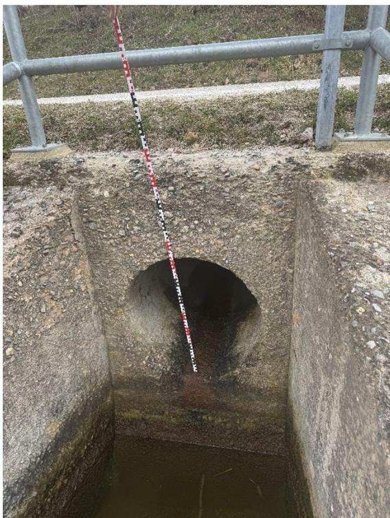
Abbildung 6: Rohreinlauf DN 700 in den Main-Donau-Kanal (eigenes Foto)
