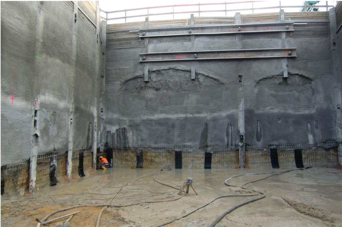
Abbildung 37: Beispiel Trägerbohlwand mit Spritzbetonausfächung (Projekt Nürnberg, Quelle: LGA)
