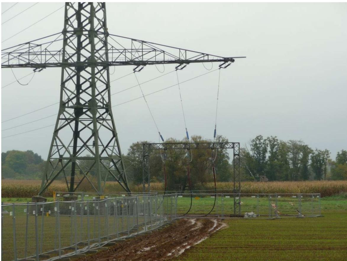
Abbildung 51: 110 kV-Kabelprovisorium mit Übergangsportal
