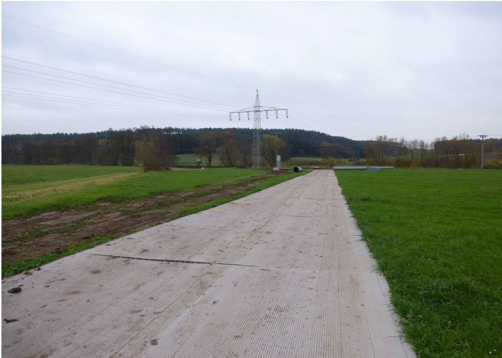
Abbildung 5: Fahrbohlen aus Aluminium (Beispielfoto)
