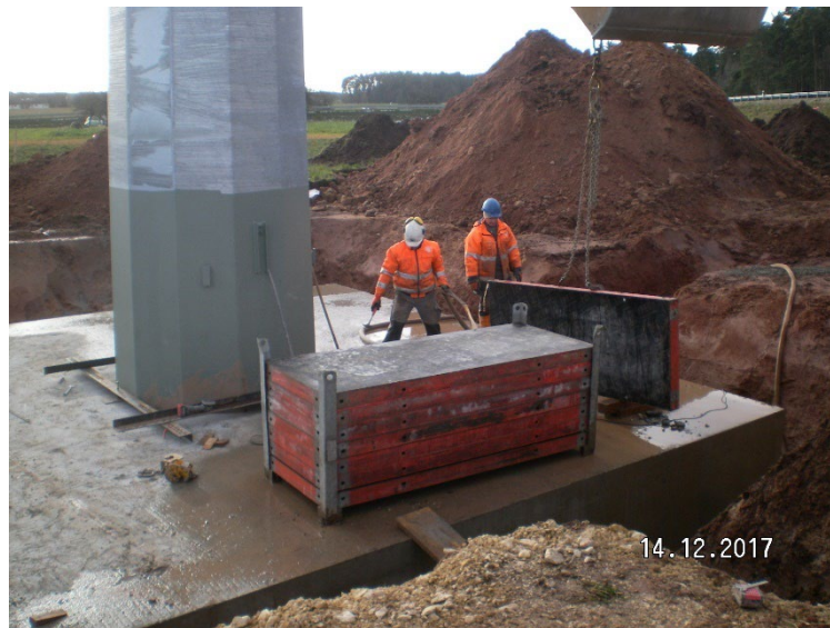
Abbildung 2: Plattenfundament eines Stahlvollwandmastes
