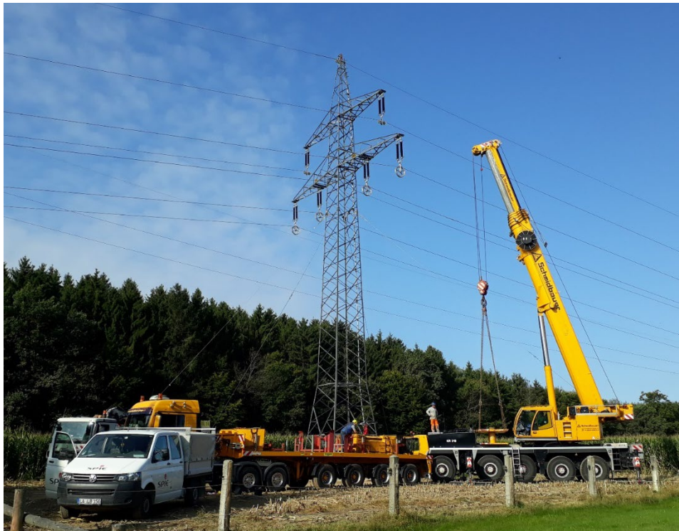
Abbildung 7: Seitlich versetzter Tragmast mit Rollen (Quelle: SPIE SAG GmbH)
