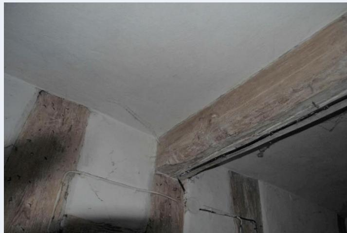
Abb. 165 – Erdgeschoß Unterzug mit Schiffskehle – 17. Jahrhundert.
