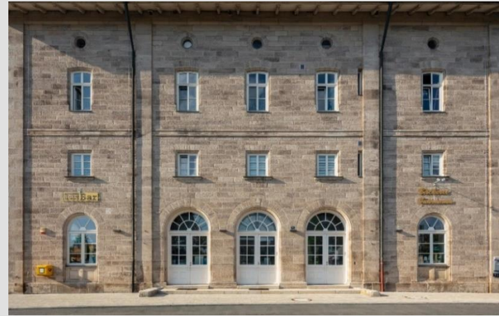
Sanierung Bahnhofsgebäude Emskirchen
