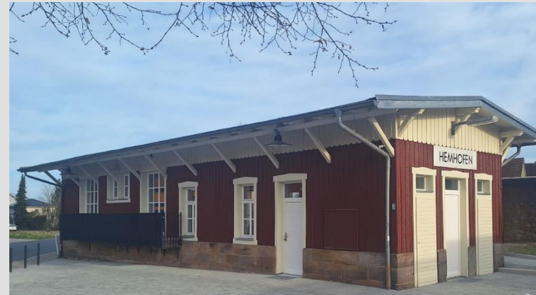
Sanierung Bahnhof Hemhofen
