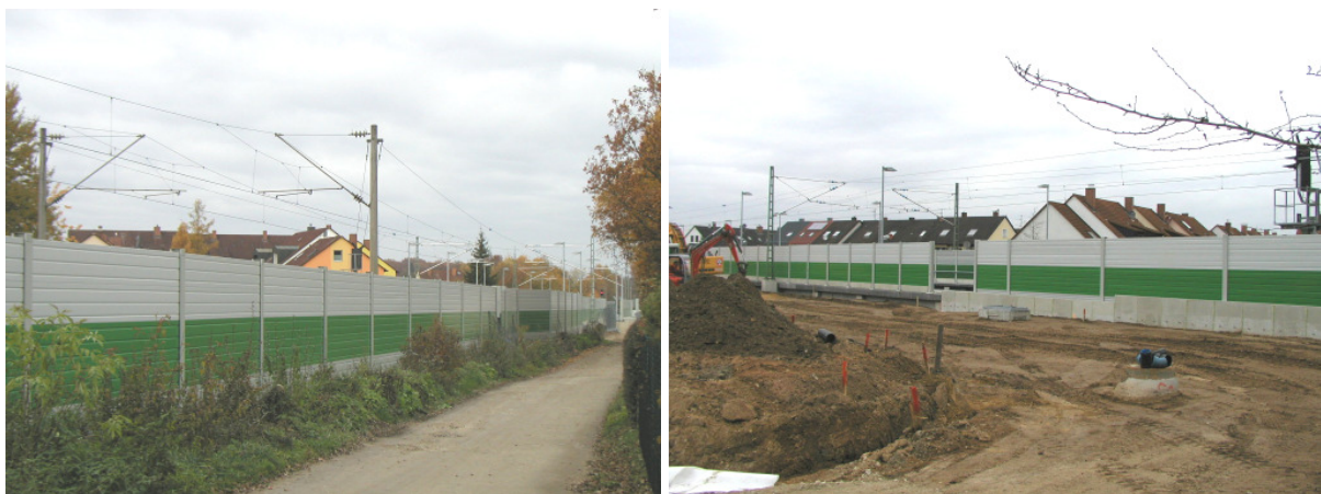
Lärmschutzwände im Bereich Feucht-Ost
